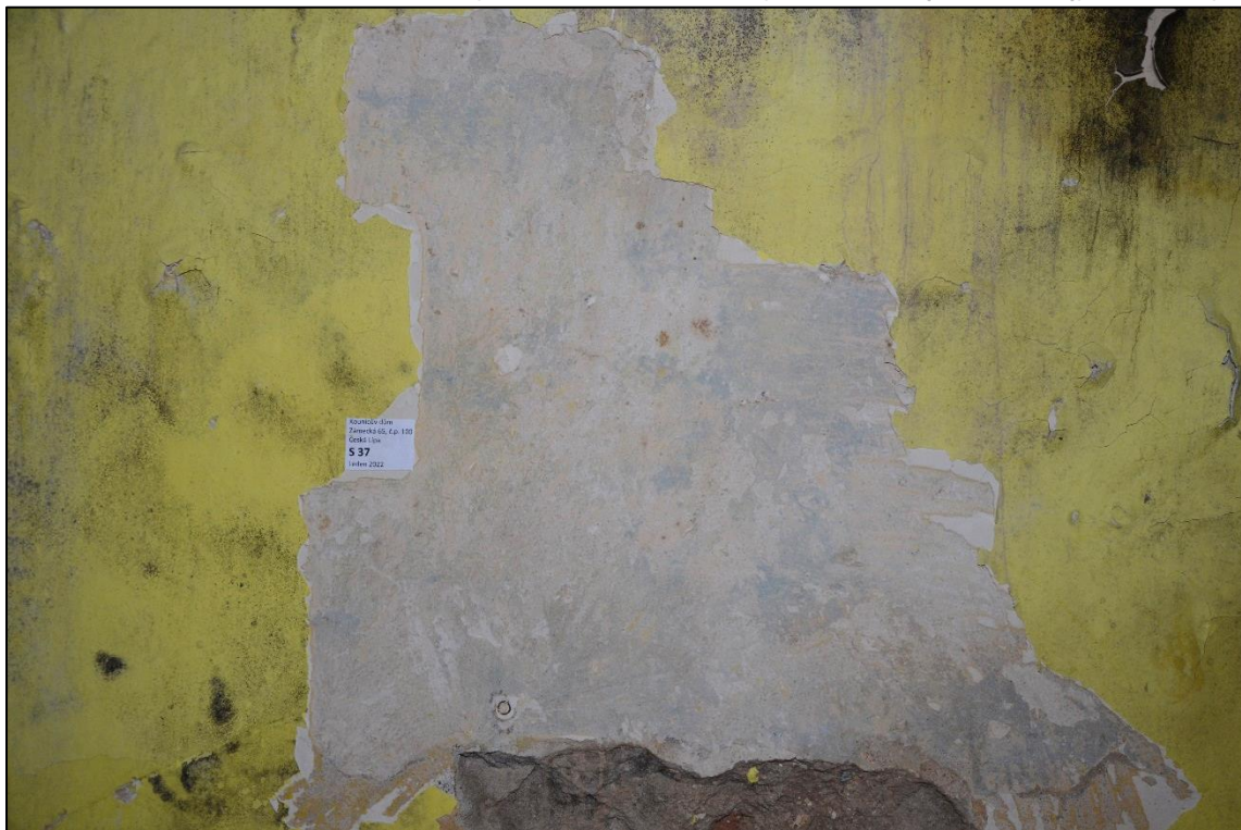
Nejstarší omítková vrstva se zbytky starších monochromních nátěrů
