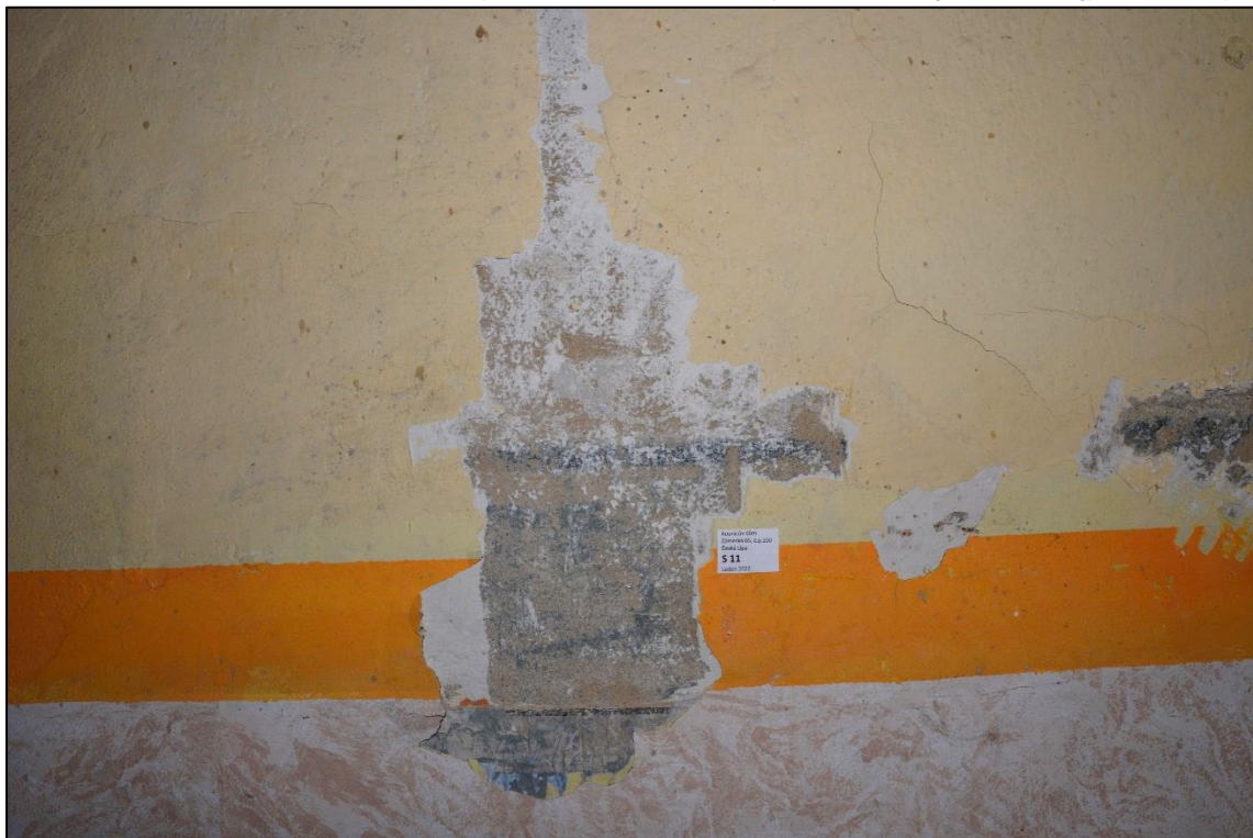
Mladší omítková vrstva s fragmenty barevnosti a členění otěrového pásu stěny
