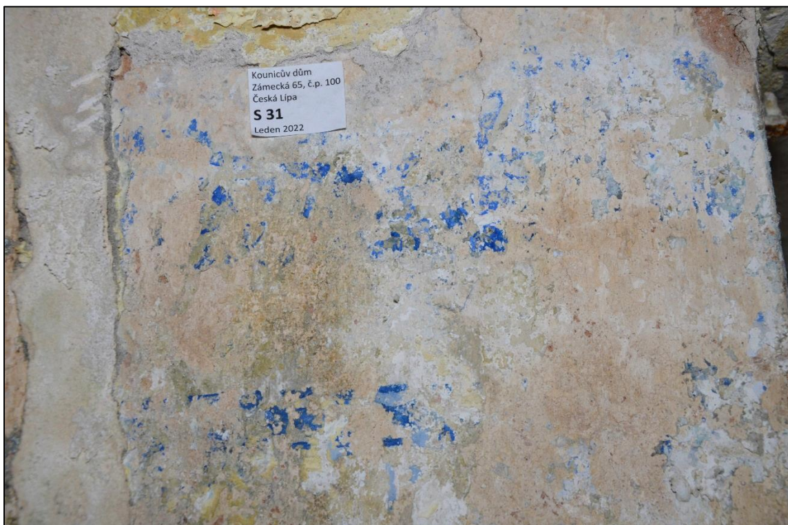
Fragmenty šablonové výzdoby (zřejmě shodná na několika místech domu), v tuto chvíli je nemožné odkrytí bez výrazných ztrát s ohledem na nabotnění pojiva zvýšenou vlhkostí v objektu
