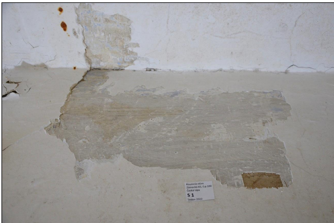
Mladší omítková vrstva s bílým a šedým vápenným nátěrem. Mladší monochromní hlinkové nátěry modré a okrové barevnosti
