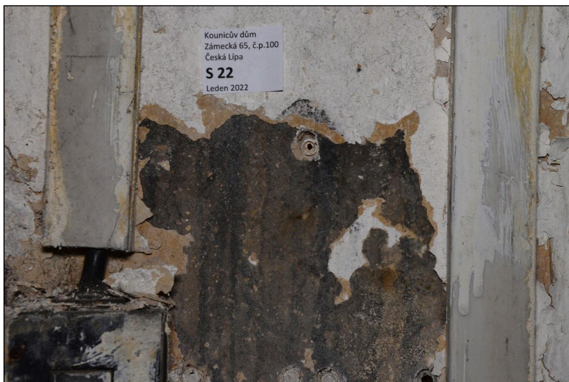
Zbytky sazí a jejich stékání po starším požáru, které jsou převrstvené monochromními vápennými a hlinkovými nátěry
