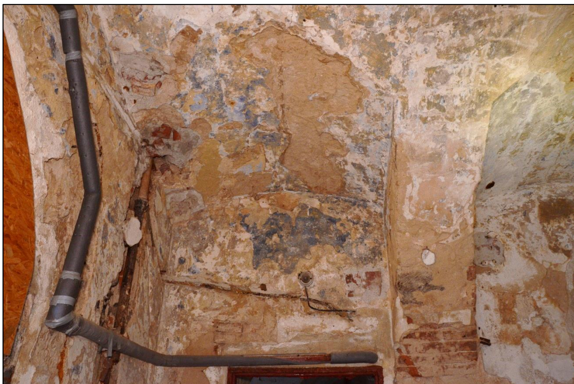
Ukázky současného stavu omítkových a barevných vrstev v klenbách přízemí hlavního křídla
