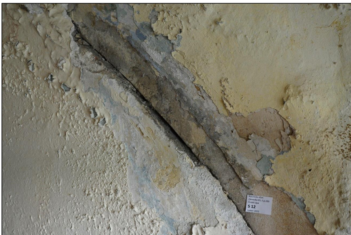
Rozhraní starší a mladší omítkové vrstvy: druhotné zazdění oblouku stěny vstupní haly s monochromními nátěry různých barevností a materiálů (na nejstarších vrstvách vápenné, mladší hlinkové)
