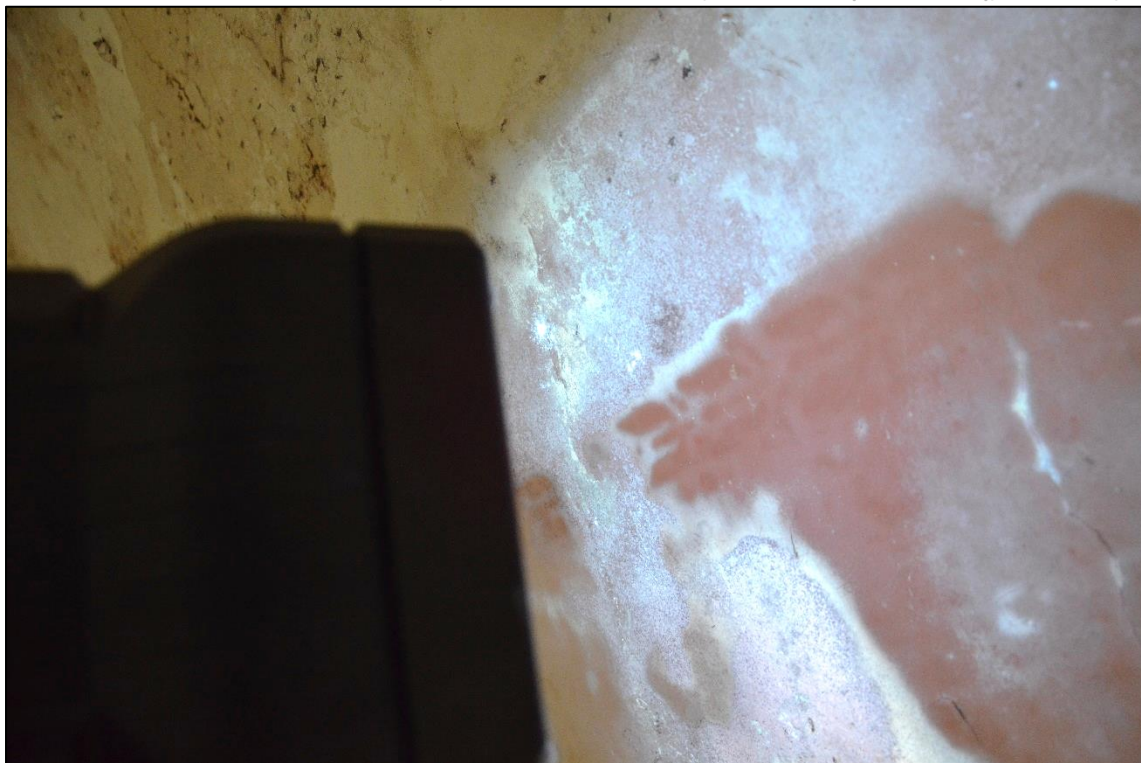
Šablonový dekor na mladší vrstvě pod souvrstvím nátěrů v UV osvětlení
