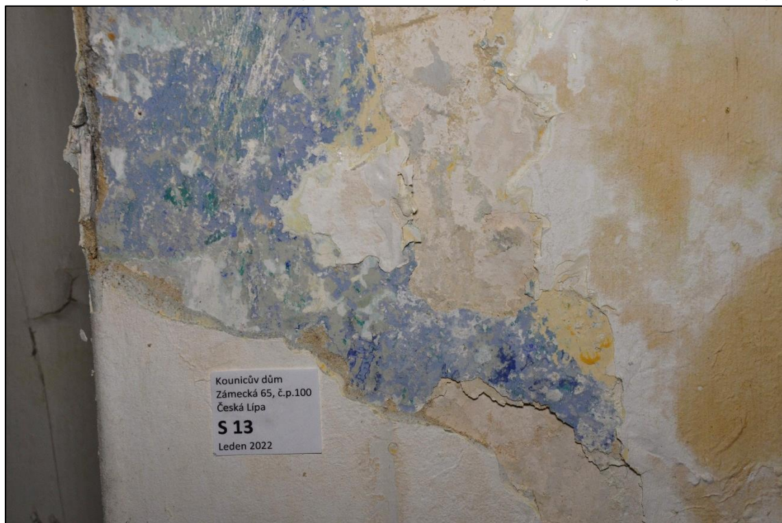
Stratigrafická sonda na starší omítkové vrstvě s fragmenty mladší hlinkové šablonové výzdoby na dvou vrstvách (modré a zelené barevnosti)
