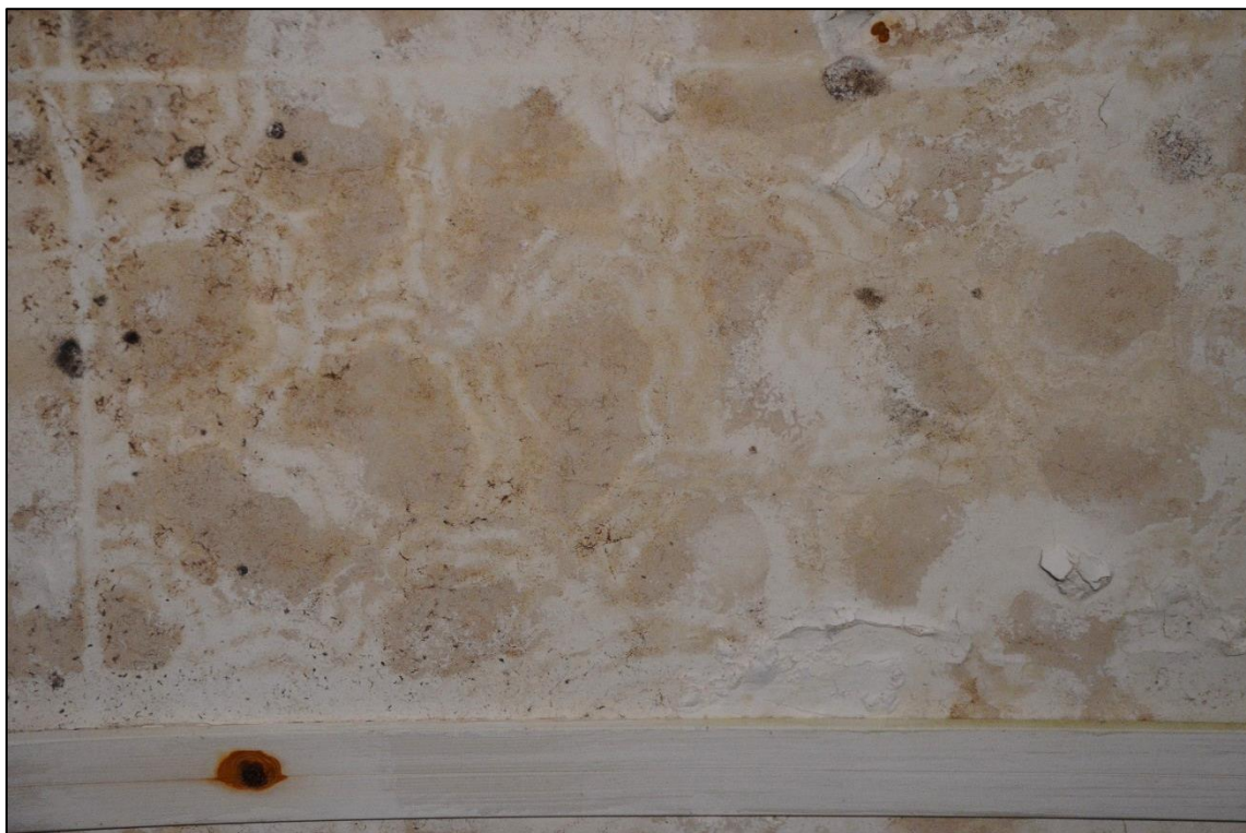
Migrace vodorozpustných solí omítkové vrstvy
