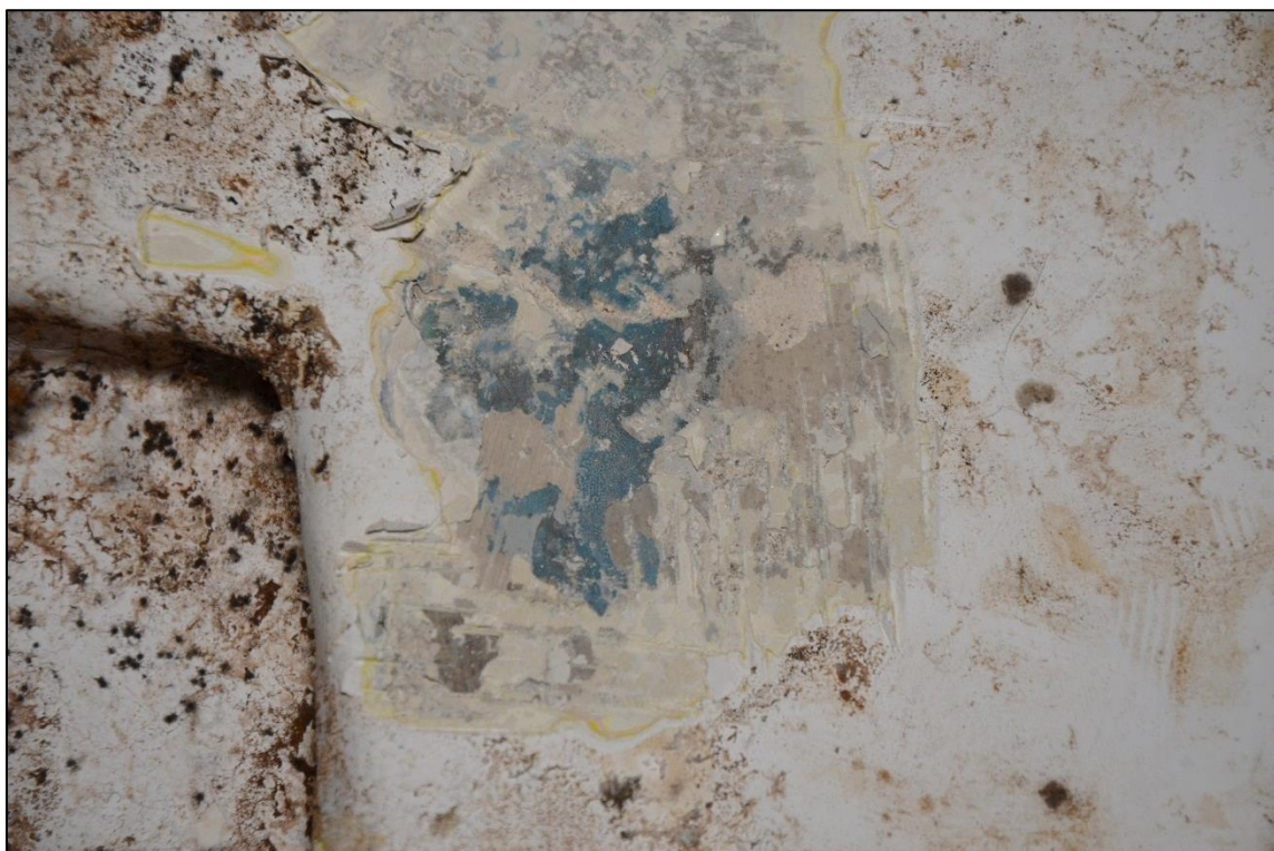
Detaily předchozího souboru sond ve vrchní části ostění: vápenné nátěry šedých a hnědošedých barevností na nejstarších vrstvách, fragmenty modrozeleného pruhu lemujícího ostění, který náleží k výzdobě stěn šablonovou výzdobou na sondách S 4 – 7, mladší monochromní hlinkové nátěry.
