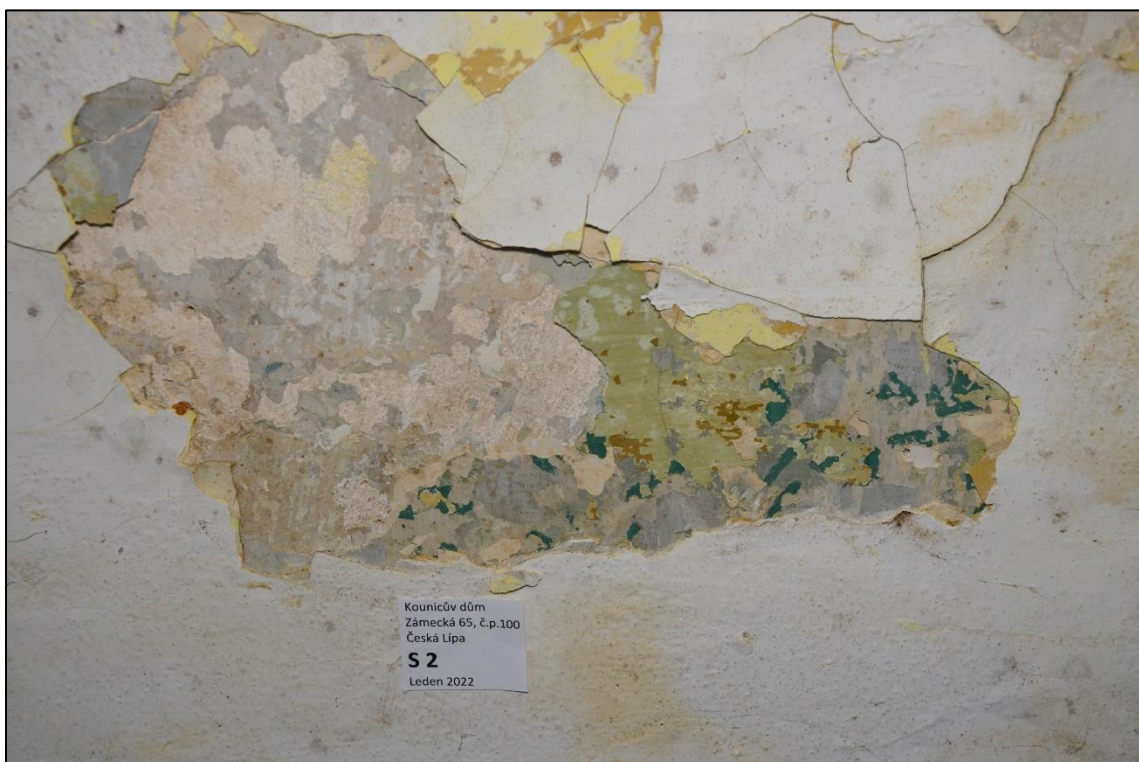
Starší omítková vrstva s šedými vápennými nátěry, mladší hlinkové barevné vrstvy s fragmenty mladší šablonové výzdoby – v této době je není možné odkrýt bez velkých ztrát s ohledem na vysokou vzdušnou vlhkost v objektu
