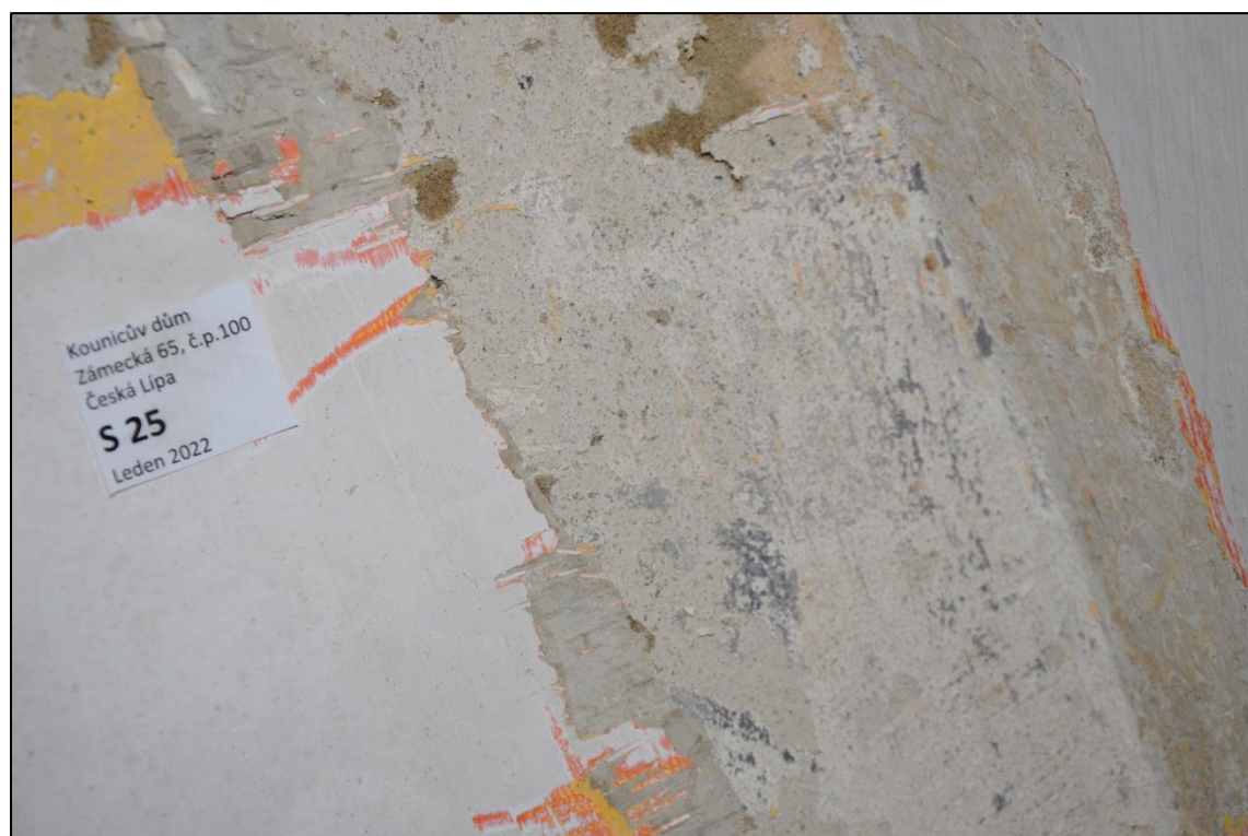
Rozhraní dvou nejstarších dochovaných omítkových vrstev s fragmenty nejstarších vápenných barevných nátěrů
