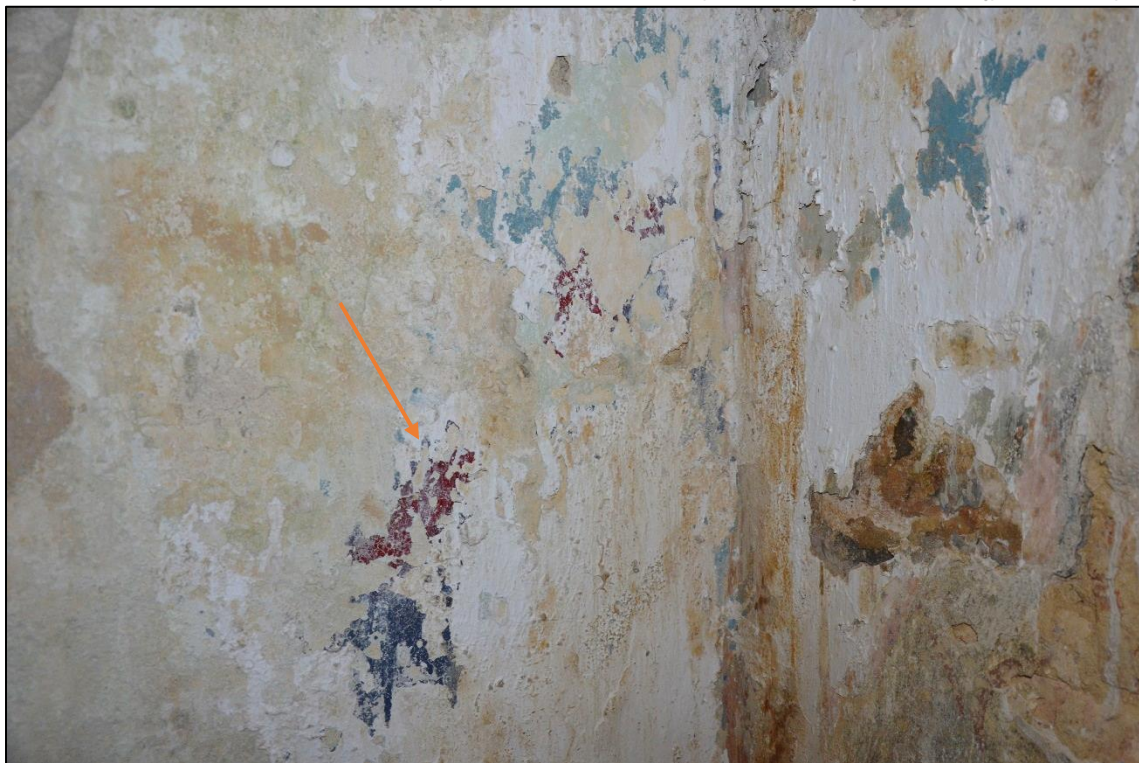
Fragmenty mladších barevných nátěrů shodné kvality jako nátěry na sondě S 8 v přízemí severovýchodní části bočního křídla
