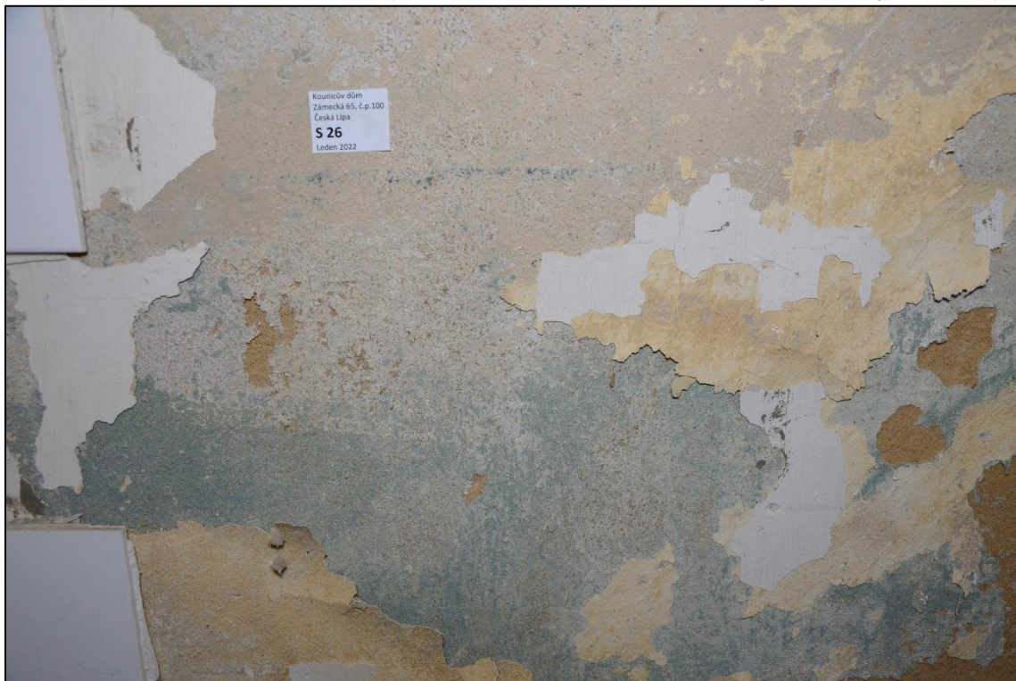
Mladší omítková vrstva s nejstarším dochovaným zeleným nátěrem v otěrové výšce
