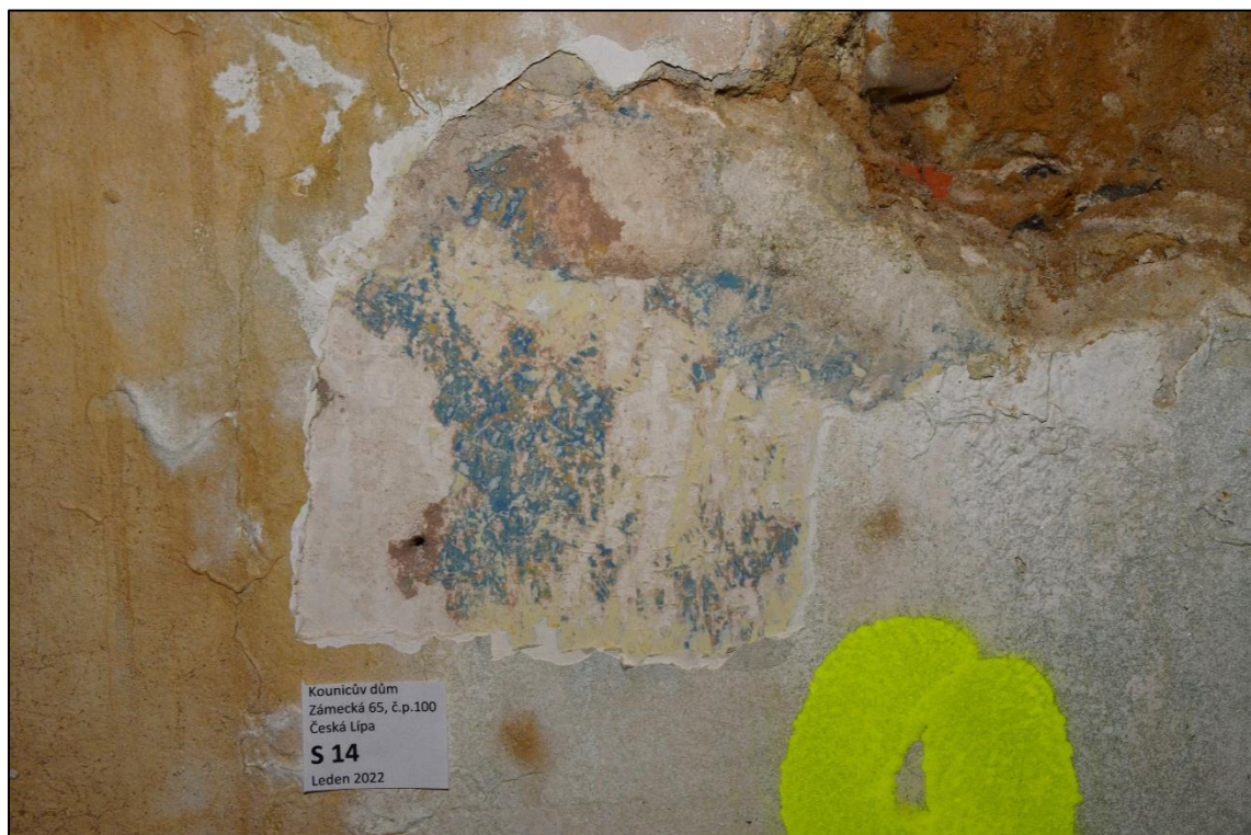
Starší omítková vrstva s nejstarší červenou vápennou barevnou vrstvou, mladší omítková vrstva s modrozelenou barevnou vrstvou, mladší hlinkové nátěry
