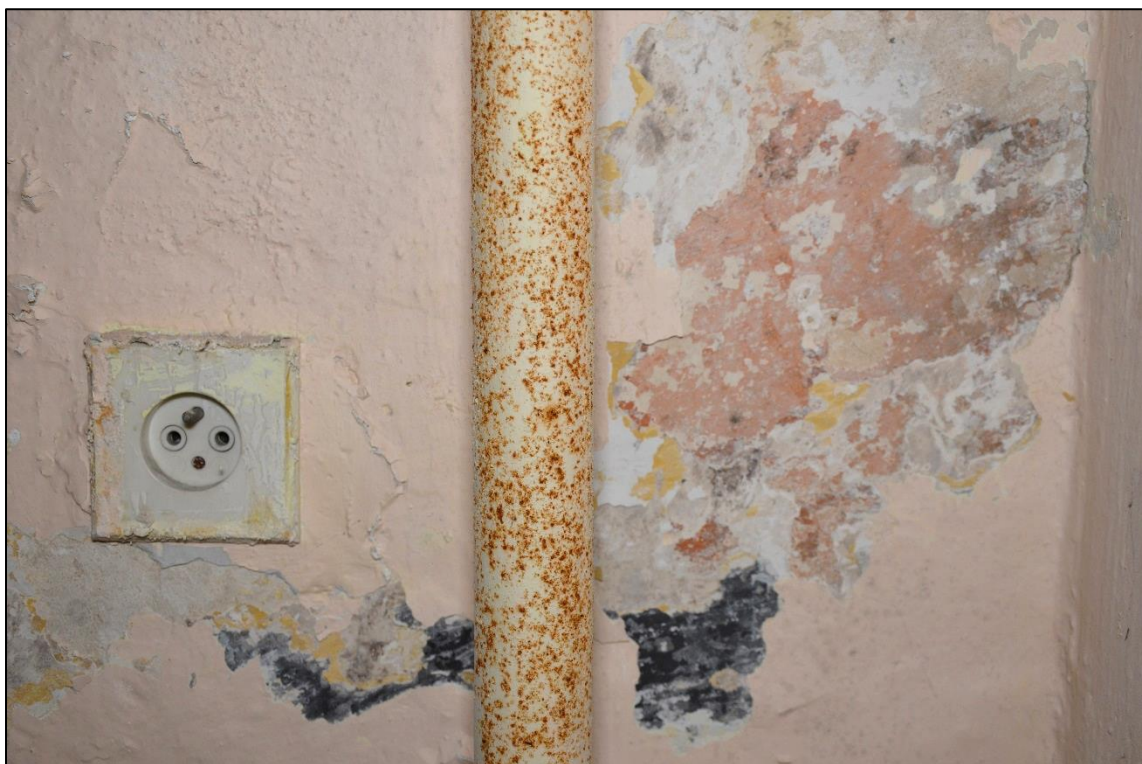
Detaily S 8 – nejstarší okrová barevnost, která se opakuje i na mladší vrstvě – na druhé stěně nejstarší červenohnědá barevnost.
