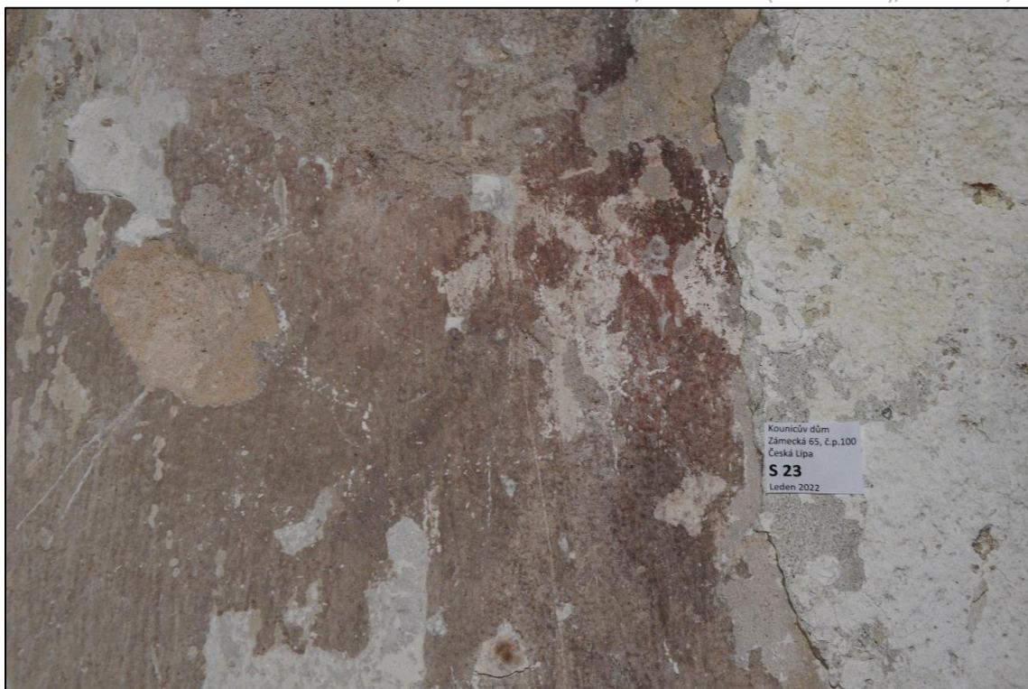
Fragment červené barevnosti na nejstarší omítkové a barevné vstvě
