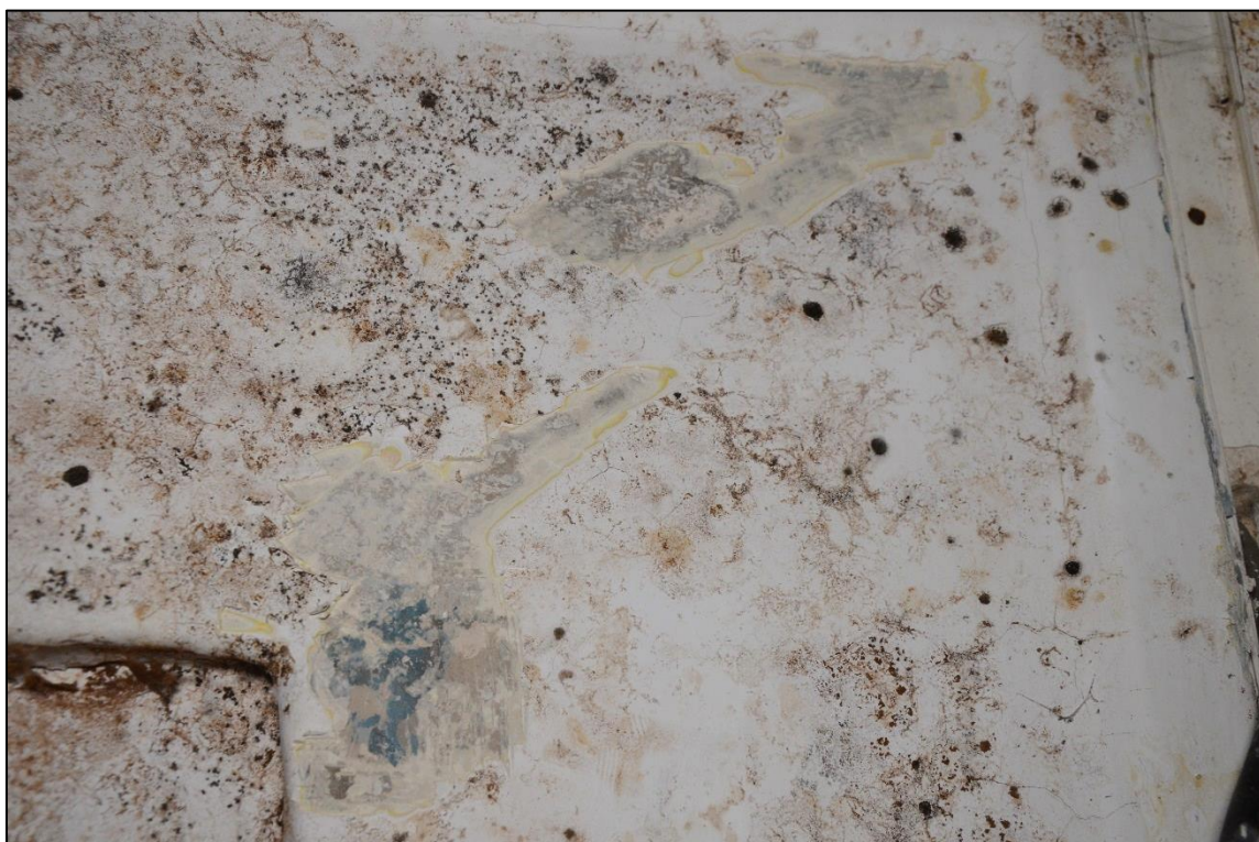
Detaily sond ze souboru S 7: vápenné nátěry šedých a hnědošedých barevností na nejstarších vrstvách, fragmenty modrozeleného pruhu lemujícího ostění, který náleží k výzdobě stěn šablonovou výzdobou na sondách S 4 – 7, mladší monochromní hlínkové nátěry, četné plísňové depozity na recentní vrstvě.
