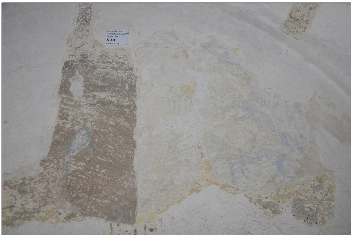
Monochromní vápenné barevné vrstvy na nejstarší omítkové vrstvě stěn pod klenbou schodišťové podesty. Vlevo nejstarší barevná vrstva, vpravo mladší barevné vrstvy.
