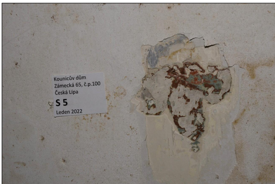
Stratigrafická sonda v místě nálezu dekoru v UV osvětlení – souvrství hlinkových nátěrů, které není možné v současné době rozkrýt bez zásadních ztrát (vysoká vzdušná vlhkost a nabotnění pojiva)
