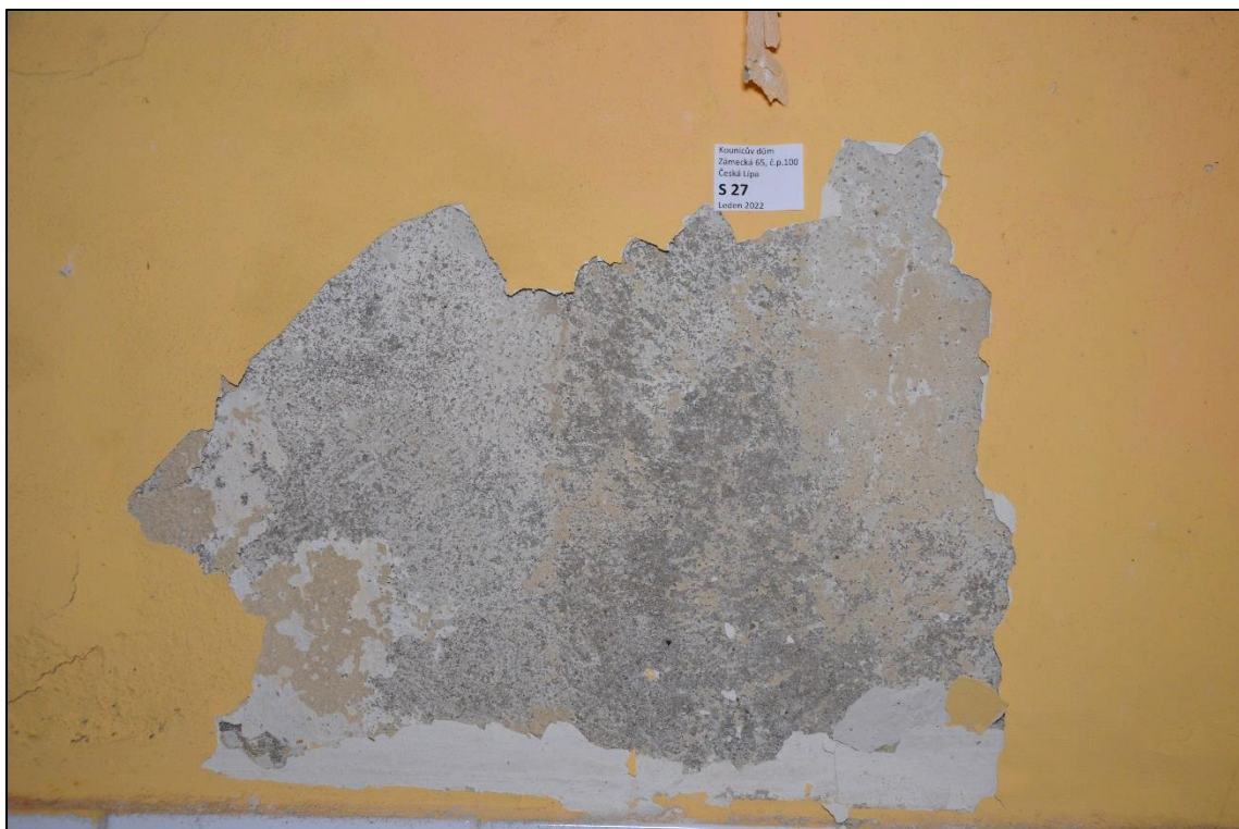
Starší omítková vrstva s fragmenty nejstarší šedé vápenné barevné vrstvy
