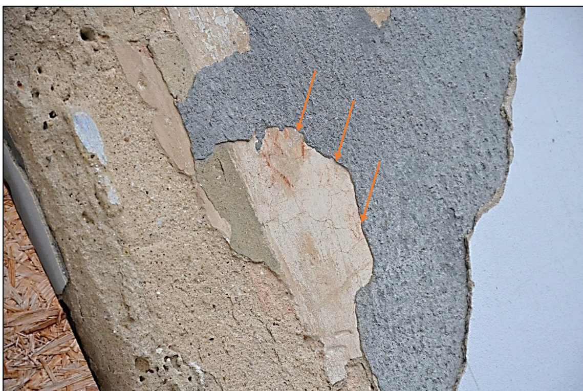
Snímek dochovaných fragmentů starších omítkových vrstev s dobovými graffiti (zřejmě nejstarší dochovaná omítková vrstva) – spodní snímek se zvýšeným kontrastem, nepřístupné ze žebříku
