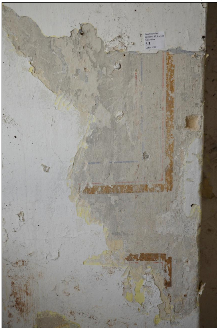
S3 a S4 na nejstarší dochované omítkové vrstvě s dochovanou výzdobou na druhé nejstarší vápenné vrstvě – S3 průběh výzdoby v okenní špaletě, S4 soutisková šablonová výzdoba stěn na téže vrstvě
