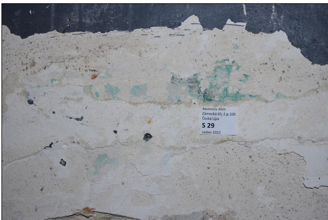
Nejstarší dochovaná omítková vrstva s fragmenty mladší barevné vrstvy původně možná s šablonovým dekorem
