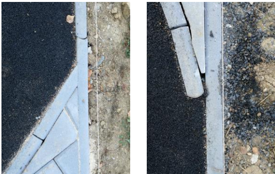
Správně provedený dořez Chybně provedené napojení
