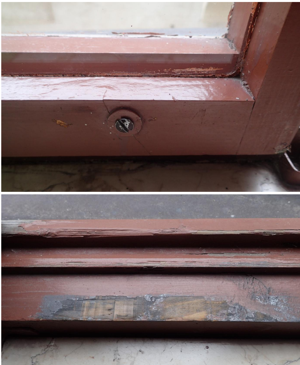
Obr. č. 24+25 Stav při průzkumu – okna /infocentrum/ 1. NP – vnější strana – detail Zdvojená konstrukce oken není narušená, křídla jsou spojená šrouby s podložkou. Lokálně a ojediněle dřou křídla o rám. Hrany jsou také lokálně poškozené. Barevný nátěr je hlavně ve spodní části popraskaný, částečně nesoudržný a na namáhaných místech často chybí.
