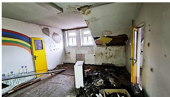
Obrázek 23, 24, 25, 26 – Pohled na interiéru prostor 4.n.p. s viditelnými vodními mapami z titulu historického dlouhodobého zatékání srážkových vod do interiéru 4.n.p. od roku 2011 ve stabilizovaném stavu bez zatékání
