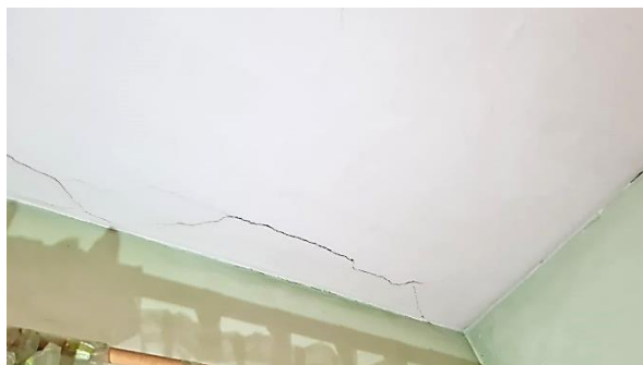
Obrázek 11, 12 – Pohled na interiér kanceláře v 1.n.p. s trhlinami v návaznosti na severovýchodní průčelí stávajícího objektu občanské vybavenosti
