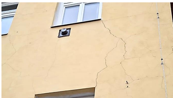
Obrázek 4, 5 – Pohled od jihovýchodu na stávající objekt občanské vybavenosti č.p. 231 v ulici Žižkova v České Lípě na p.p.č. 332, k.ú. Česká Lípa – viditelné trhliny na fasádě
