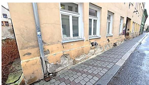
Obrázek 6, 7, 8, 9, 10 – Pohled od severovýchodu na stávající objekt občanské vybavenosti č.p. 231 v ulici Žižkova v České Lípě na p.p.č. 332, k.ú. Česká Lípa – viditelné trhliny na fasádě a zvýšená vlhkost u soklových částí
