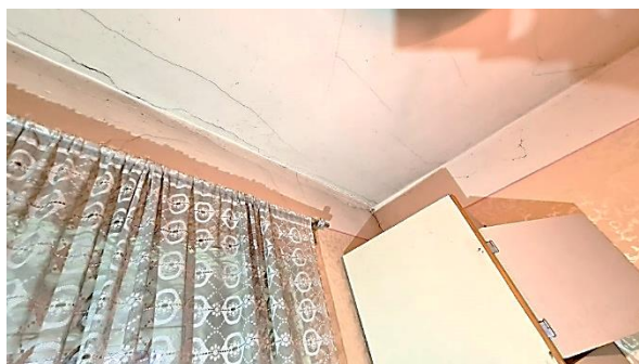
Obrázek 11, 12 – Pohled na interiér kanceláře v 1.n.p. s trhlinami v návaznosti na severovýchodní průčelí stávajícího objektu občanské vybavenosti
