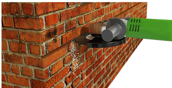
Obrázek 35 – Frézování drážky
