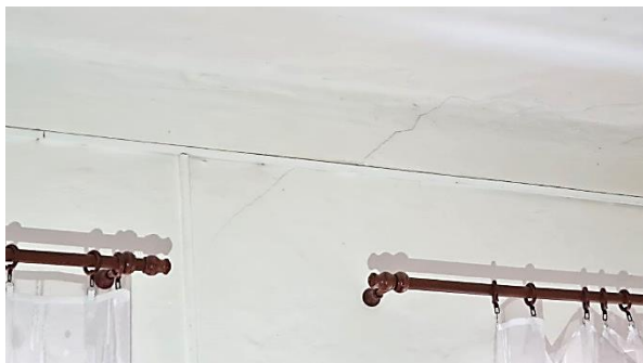
Obrázek 17, 18 – Pohled na interiér kanceláře ve 2.n.p. s trhlinami v návaznosti na severovýchodní průčelí stávajícího objektu občanské vybavenosti
