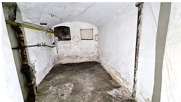
Obrázek 19, 20, 21, 22 – Pohled na interiér prostor v úrovni 1.n.p. až 1.p.p. se zvýšenou vlhkostí svislých konstrukcí stěn vlivem absence nebo dožilosti izolace proti zemní vlhkosti na severovýchodní průčelí stávajícího objektu občanské vybavenosti
