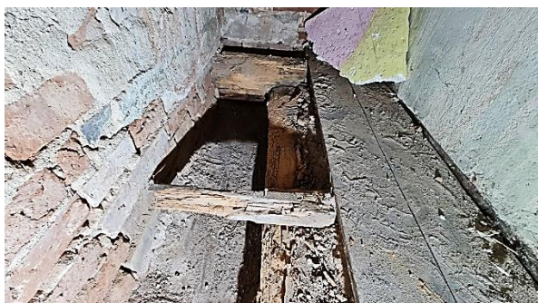
Obrázek 13, 14, 15, 16 – Pohled na interiér kanceláře Městské lesy ve 3.n.p. s trhlinami a nadměrným průhybem v omítném rákosovém podhledu a pohled nad v interiéru 4.n.p. s napadením a oslabením dřeva stávajících dřevěných stropních trámů dřevokazným hmyzem v návaznosti na jihozápadní průčelí stávajícího objektu občanské vybavenosti
