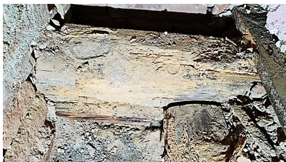
Obrázek 13, 14, 15, 16 – Pohled na interiér kanceláře Městské lesy ve 3.n.p. s trhlinami a nadměrným průhybem v omítném rákosovém podhledu a pohled nad v interiéru 4.n.p. s napadením a oslabením dřeva stávajících dřevěných stropních trámů dřevokazným hmyzem v návaznosti na jihozápadní průčelí stávajícího objektu občanské vybavenosti
