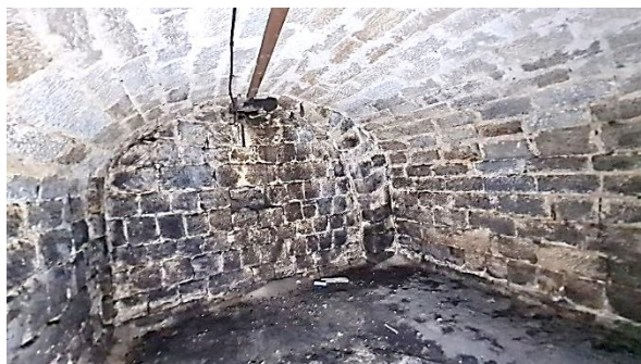
Obrázek 19, 20, 21, 22 – Pohled na interiér prostor v úrovni 1.n.p. až 1.p.p. se zvýšenou vlhkostí svislých konstrukcí stěn vlivem absence nebo dožilosti izolace proti zemní vlhkosti na severovýchodní průčelí stávajícího objektu občanské vybavenosti
