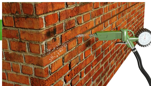
Obrázek 36 – Vyčištění drážky
