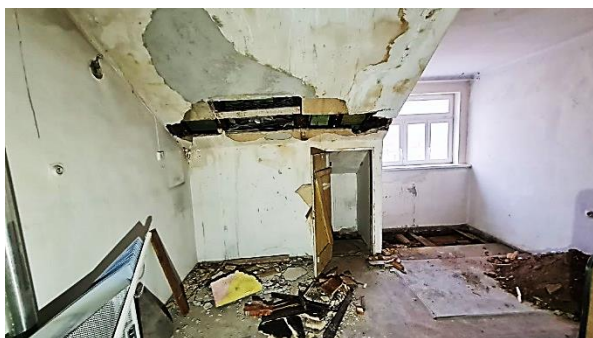
Obrázek 23, 24, 25, 26 – Pohled na interiéru prostor 4.n.p. s viditelnými vodními mapami z titulu historického dlouhodobého zatékání srážkových vod do interiéru 4.n.p. od roku 2011 ve stabilizovaném stavu bez zatékání
