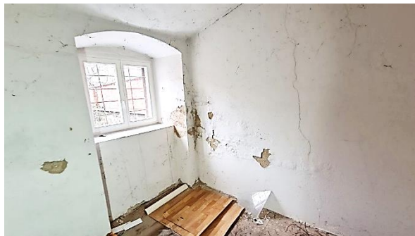
Obrázek 17, 18 – Pohled na interiér kanceláře ve 2.n.p. s trhlinami v návaznosti na severovýchodní průčelí stávajícího objektu občanské vybavenosti
