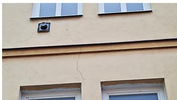
Obrázek 6, 7, 8, 9, 10 – Pohled od severovýchodu na stávající objekt občanské vybavenosti č.p. 231 v ulici Žižkova v České Lípě na p.p.č. 332, k.ú. Česká Lípa – viditelné trhliny na fasádě a zvýšená vlhkost u soklových částí
