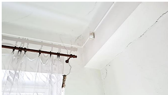
Obrázek 17, 18 – Pohled na interiér kanceláře ve 2.n.p. s trhlinami v návaznosti na severovýchodní průčelí stávajícího objektu občanské vybavenosti
