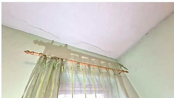
Obrázek 11, 12 – Pohled na interiér kanceláře v 1.n.p. s trhlinami v návaznosti na severovýchodní průčelí stávajícího objektu občanské vybavenosti
