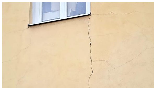
Obrázek 4, 5 – Pohled od jihovýchodu na stávající objekt občanské vybavenosti č.p. 231 v ulici Žižkova v České Lípě na p.p.č. 332, k.ú. Česká Lípa – viditelné trhliny na fasádě
