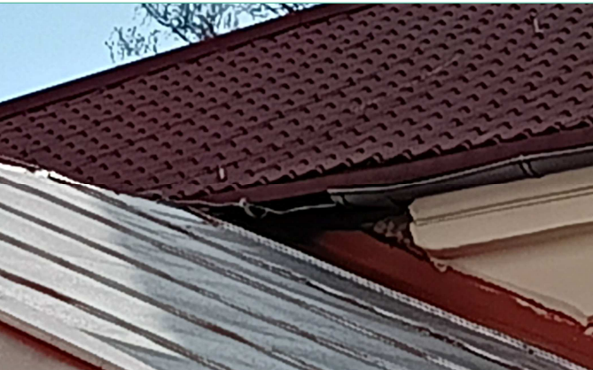
Detail stávajícího napojení střech. Nutno upravit tesařsky i klempířsky na místě po rozebrání střešní krytiny a zdokumentování skutečného stavu.
