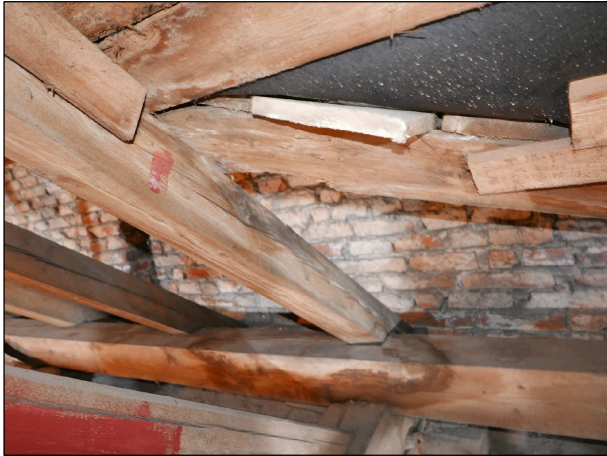
Zatékání u útlabí - mokrá pozednic
