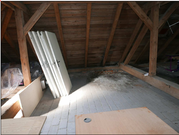
Zatékání netěsnou střechou
