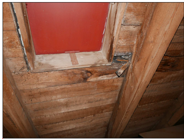
Zatékání u střešního okna
