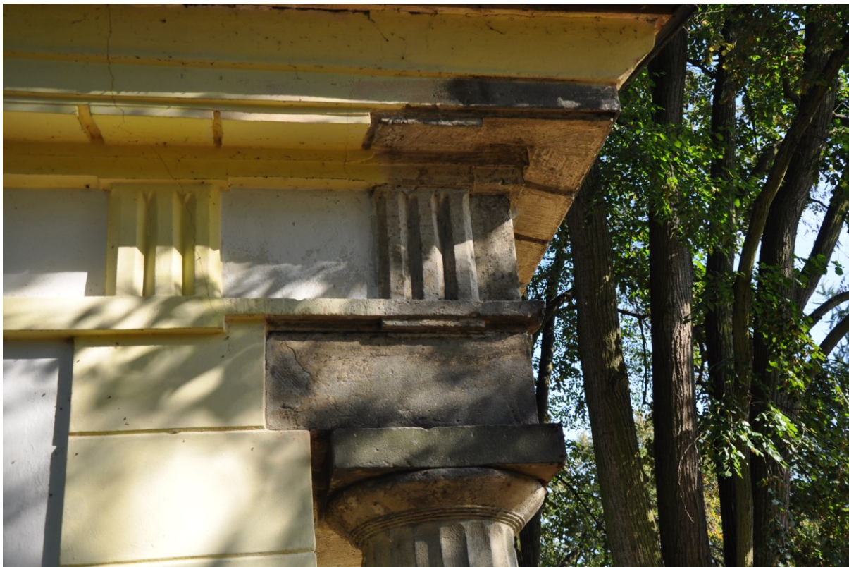
Obrázek 11 – Detail rozhraní kamenných prvků s přiznaným kamenným povrchem a natřeného zbytku fasády
