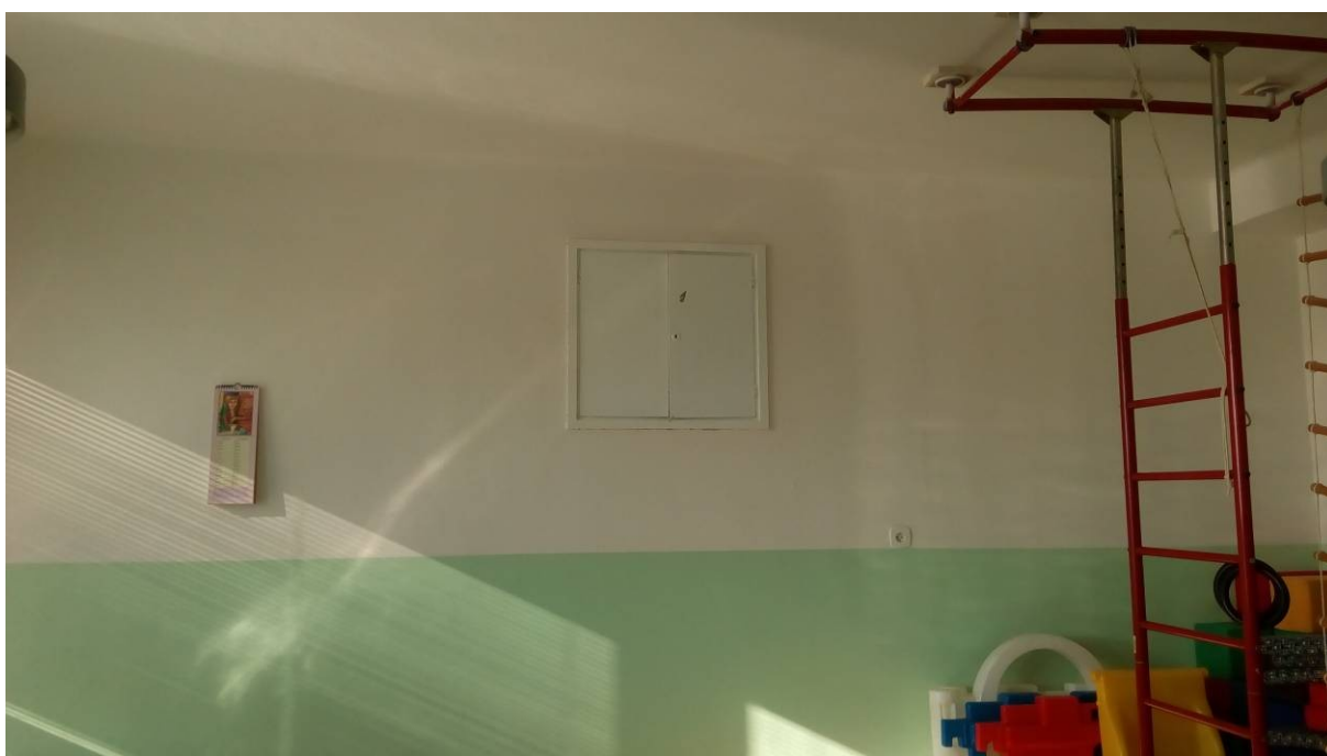
Dveře strojovny výtahu v 2.NP – pravý výtah
