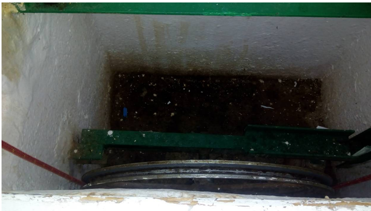
Dno výtahové šachty v 1. NP
