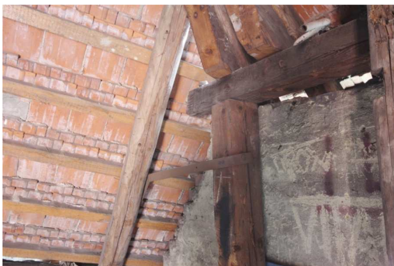
Krov B. Jižní strana východní část. Detail železného spoje mezi krajním sloupkem přístěnné stolyce a východní krokví
