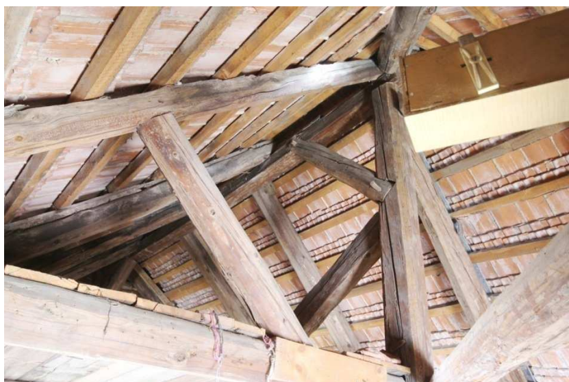
Krov B. Detail v místě jižního sloupku hřebenové stolice (pohled k severovýchodu)
