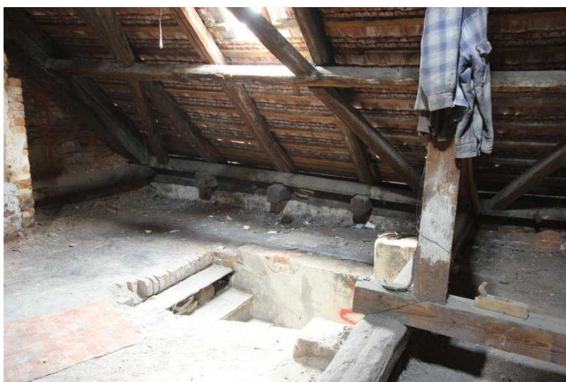
Krov A. Spodní partie západní střešní roviny v rozsahu prvních 2 celých plných příčných vazeb od jihu. Na snímku vpravo detail založení krovu na trámovou pozednici. Na snímcích jsou dobře patrné zbytky vazných trámů u mezilehlých vazeb (trámy sekundárně vyřezané)
