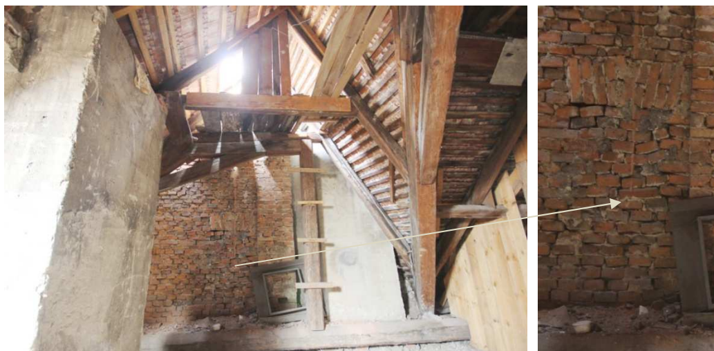
Krov A. Pohled k severní štítové zdi. Na snímku vpravo detail transportního/pracovního otvoru, souvisejícího s dopravou stavebního materiálu při stavbě domu
