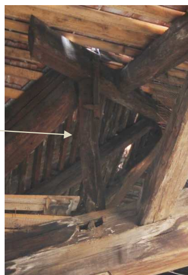
Krov A. Pohled k východu. Detail úžlabní polovazby a detail podepření "západní" nárožní krokve valby sloupkem. Černá šipka ukazuje na dlab v hambalku 10. vazby od jihu v místě, kde probíhala hlavní pětiboká vaznice
