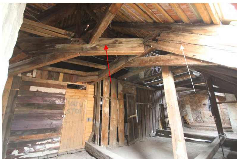
Krov A. Pohled k jihovýchodu do místa napojení 9. celé plné příčné vazby od jihu (viz bílá šipka) a úžlabní polovazby (viz červená šipka). Na detailu vpravo vrchol sloupku ležaté stolice s čepem pro nasazení hlavní pětiboké vaznice
