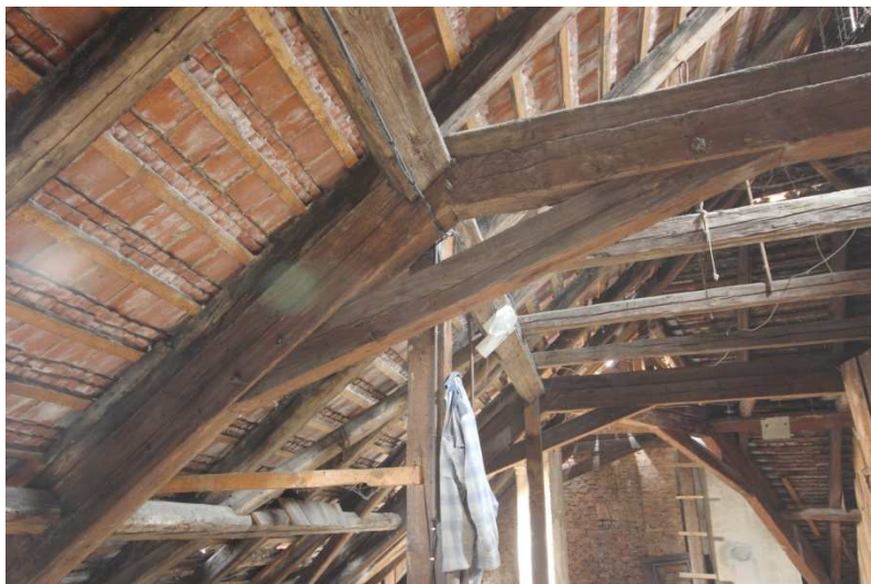
Krov A. Detail plné vazby krovu
