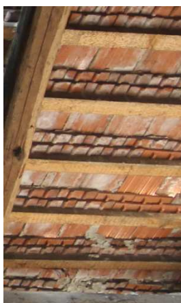
Střecha A. Detaily krytiny při pohledu z podkrovní. Zleva: východní střešní rovina, západní střešní rovina, severní konec sedlové střechy při valbě, severní valba
