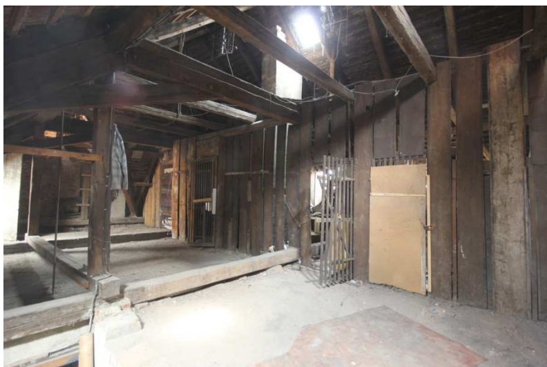
Krov A. Pohled k severu. Na snímku jsou patrné bedněné stěny vymezující čtveřici půdních kójí na východní straně podkroví
