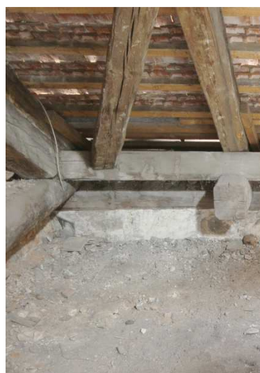
Krov A. Spodní partie západní střešní roviny v rozsahu prvních 2 celých plných příčných vazeb od jihu. Na snímku vpravo detail založení krovu na trámovou pozednici. Na snímcích jsou dobře patrné zbytky vazných trámů u mezilehlých vazeb (trámy sekundárně vyřezané)
