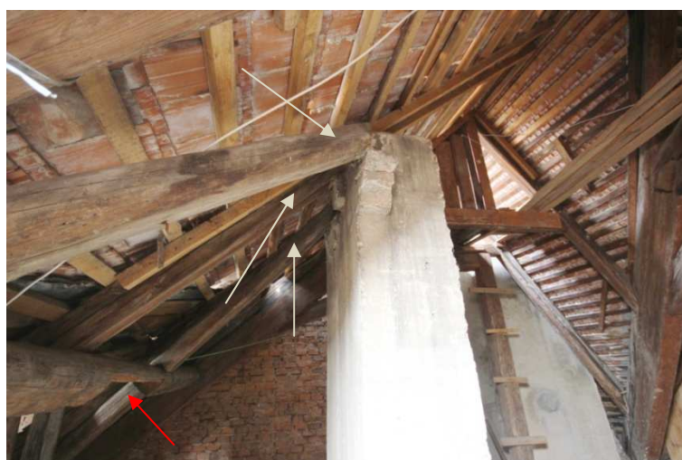
Krov A. Pohled k severu na severní úsek sedlového zastřešení při štítové zdi. Šipky ukazují na odřezané konce západní krokve 12. vazby od jihu a vzpěr v rovině střechy (kvůli mladší stavbě severního komínu). Červená šipka ukazuje na pozici druhotného výřezu u mezilehlé vaznice v místě vstupu do podkrovní krovu B
