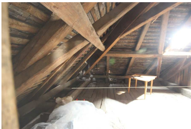
Krov A. Pohled k východu do místa severní valby střechy, resp. do severní půdní kóje. Na snímku vpravo detail krátkete jedné ze severních polovazeb valby, začepovaného do krajního severního vazného trámu
