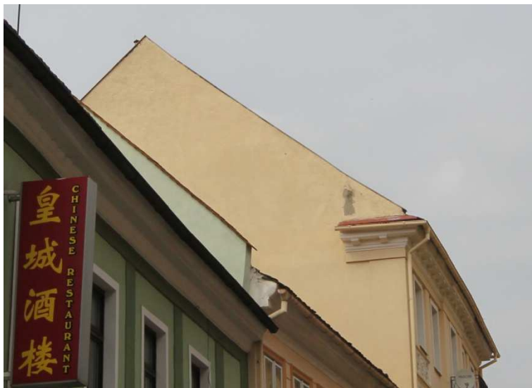
Střecha A. Pohled od jihu. Na jižní straně je střecha vymezena zděným štítem. Na snímku vpravo detail s okapem v místě korunní římsy
