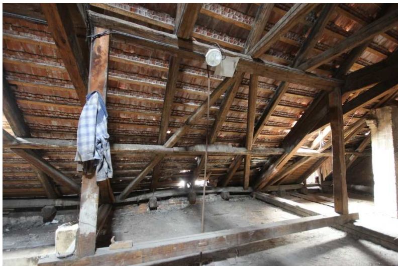
Krov A. Detail západní strany v rozsahu 2. a 3. celé plné příčné vazby. Hlavní pětibokou vaznici zde podpírá druhotně vložená dvojice sloupků založených do trámového prahu
