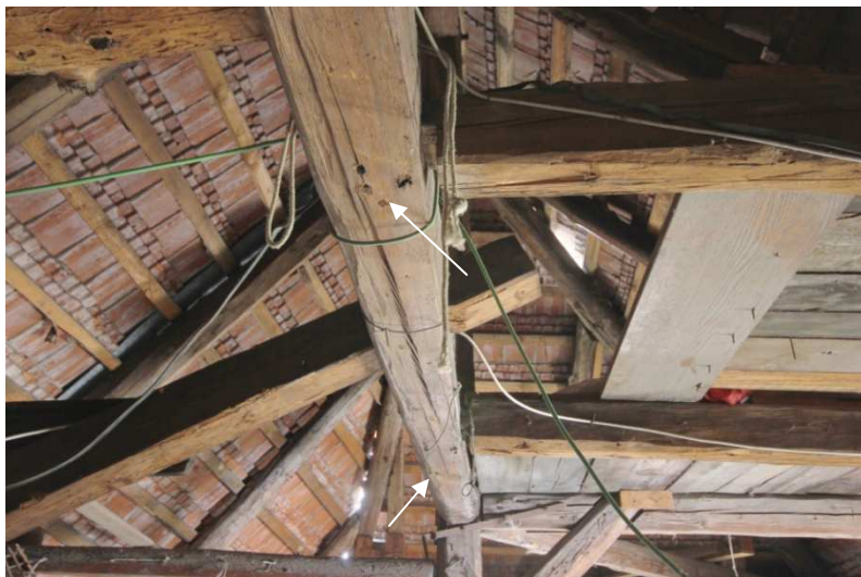
Krov B. Pohled k jihu na spojení hambalků západních krokví s rozpěrou hřebenové stolice. Bílé šipky ukazují do míst vývrtů pro vtlučení dřevěných hřebů u čepových spojů
