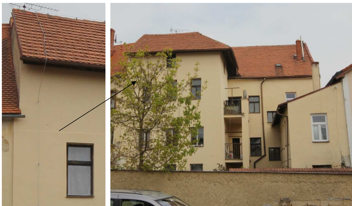
Pohled na dům od západu (na snímku vpravo) - vlevo severní křídlo, vpravo křídlo jižní. Na snímku vlevo je patrný přechod na fasádě severního dvorního křídla mezi 2. patrem a 3. (půdním) patrem, což je jednou z indicií pro mladší vznik tohoto půdního podlaží
