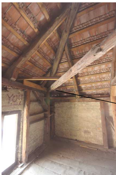
Krov B. Vlevo: pohled k západu na konstrukci valby. Uprostřed: pohled do jihozápadního nároží valby. Vpravo: detail spoje mezi hambalkem a nárožní krokví valby
