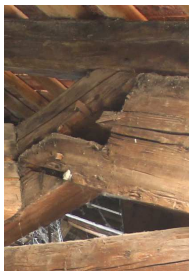
Krov A. Pohled k jihovýchodu do místa napojení 9. celé plné příčné vazby od jihu (viz bílá šipka) a úžlabní polovazby (viz červená šipka). Na detailu vpravo vrchol sloupku ležaté stolice s čepem pro nasazení hlavní pětiboké vaznice
