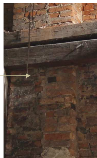
Krov A. Pohled na jižní štít a detail dodatečného zesílení jeho středového polopilíře
