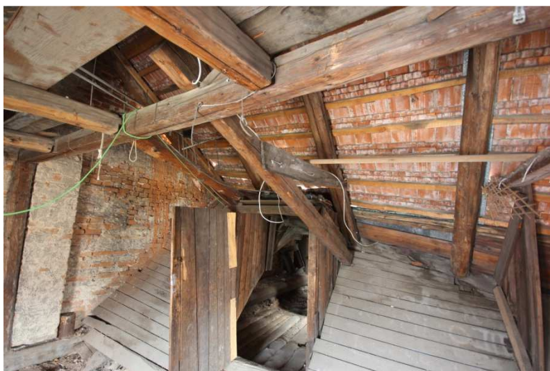
Krov B. Pohled na východní stranu se vstupem z podkroví střechy A. Na snímku je dobře patrný průnik západní střešní roviny střechy A s vodorovným bedněním na krokách jejího krovu
