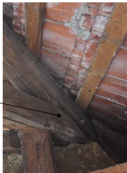
Krov B. Vlevo: pohled k západu na konstrukci valby. Uprostřed: pohled do jihozápadního nároží valby. Vpravo: detail spoje mezi hambalkem a nárožní krokví valby
