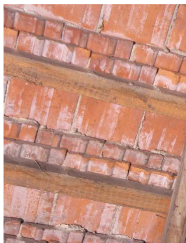
Střecha B. Detaily krytiny při pohledu z podkrovní. Zleva: západní střešní rovina, východní střešní rovina, jižní valba
