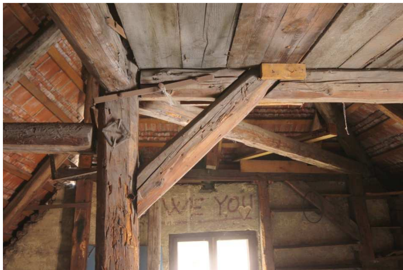
Krov B. Detail pásku u jižního sloupku hřebenové stolice (pohled k jihu)
