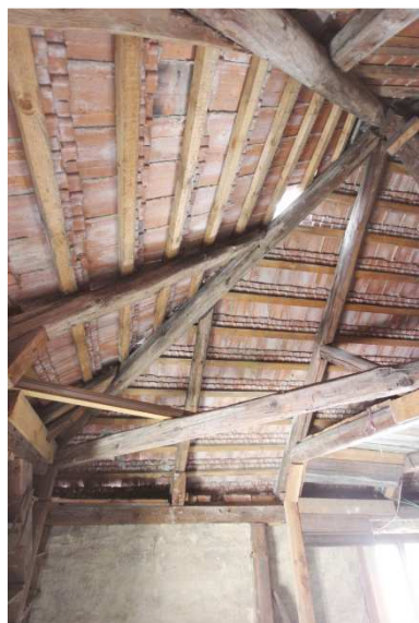
Krov B. Vlevo: pohled k západu na konstrukci valby. Uprostřed: pohled do jihozápadního nároží valby. Vpravo: detail spoje mezi hambalkem a nárožní krokví valby
