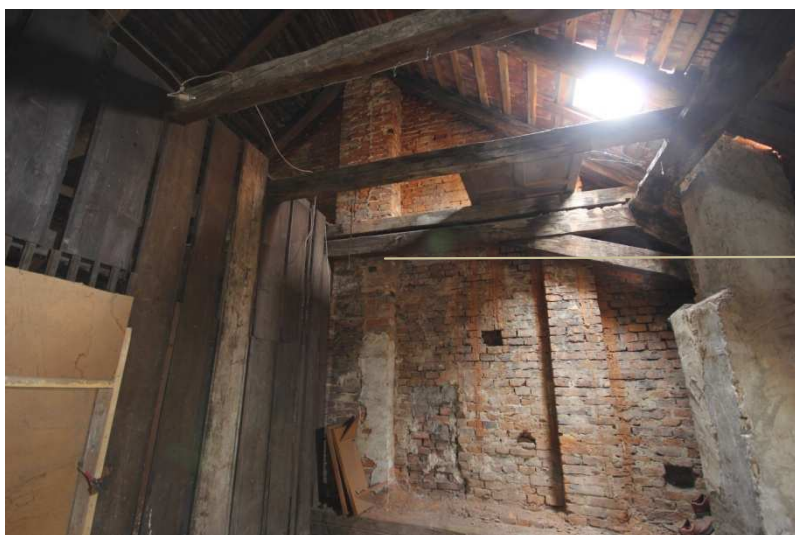
Krov A. Pohled na jižní štít a detail dodatečného zesílení jeho středového polopilíře
