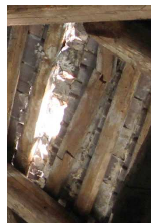
Střecha A. Detaily krytiny při pohledu z podkrovní. Zleva: východní střešní rovina, západní střešní rovina, severní konec sedlové střechy při valbě, severní valba
