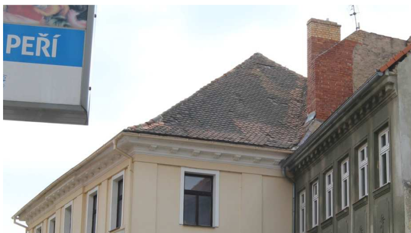
Střecha A. Pohled na valbu od severu. Na snímku vpravo detail úžlabí mezi valbou a sedlovou částí střechy
