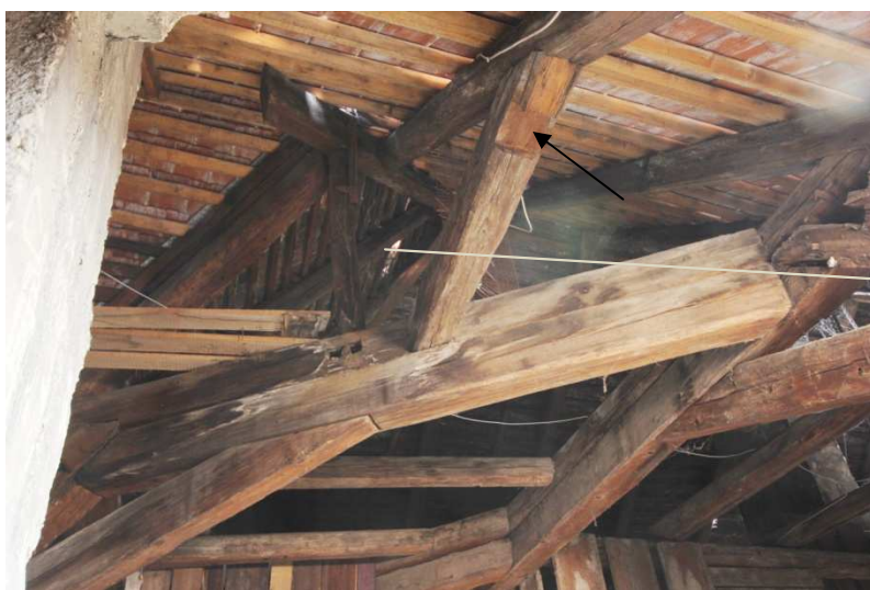
Krov A. Pohled k východu. Detail úžlabní polovazby a detail podepření "západní" nárožní krokve valby sloupkem. Černá šipka ukazuje na dlab v hambalku 10. vazby od jihu v místě, kde probíhala hlavní pětiboká vaznice
