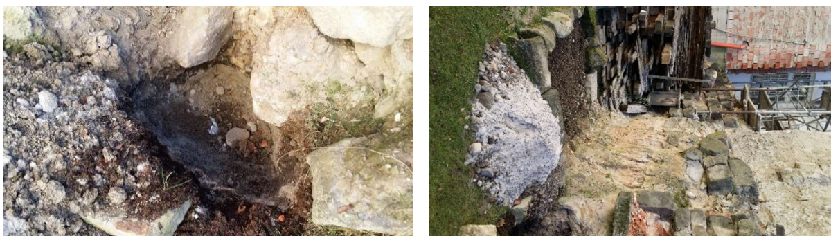
Obrázek 1, Obrázek 2 – Kopaná sonda podloží v místě dělící zdi
