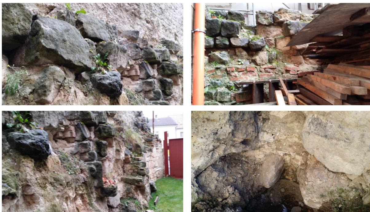
Obr.10,11,12,13 – Pohled na kvalitu smíšeného zdiva z kamene a cihel stávající ohradní a dělicí zdi z pozemku p.č.191, k.ú. Česká Lípa
