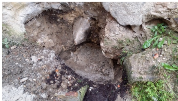
Obr.8,9 – Pohled na provedenou kopanou sondu u stávající ohradní a dělicí zdi na pozemku p.č.191, k.ú. Česká Lípa
