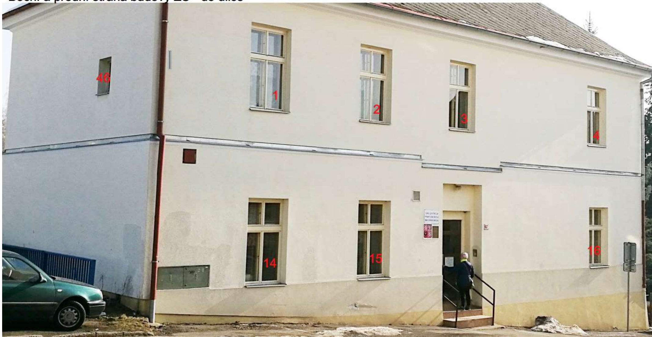
Boční a přední strana budovy ZŠ - do ulice
