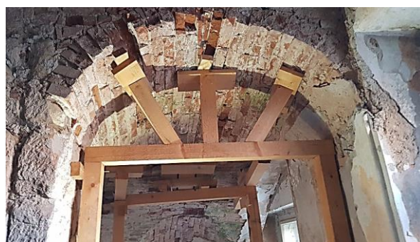
Obrázek 11, 12, 13, 14, 15 – Provizorní podepření kleneb konstrukce vnitřního schodiště mezi 1.n.p. až 3.n.p. a klenbových pásů nad 2.n.p.
