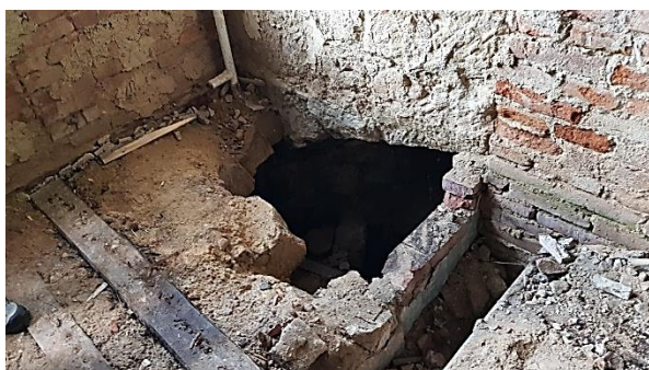
Obrázek 22, 23 – Zaslepený otvor ve stropní konstrukci nad 1.n.p. (kontrolní otvor pro zjištění původního historického schodiště při severní části severního křídla objektu)
