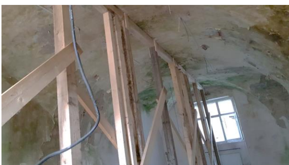
Obrázek 7, 8, 9, 10 – Provizorní podepření klenbové stropní konstrukce nad 1.n.p. v severním křídle při západní části
