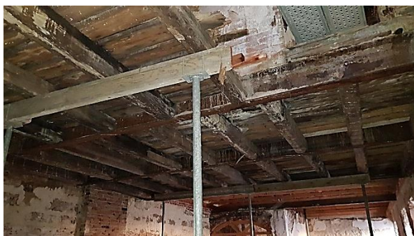
Obrázek 16, 17 – Provizorní podepření stropní konstrukce nad 2.n.p. – napadení dřevokaznou houbou a plísněmi
