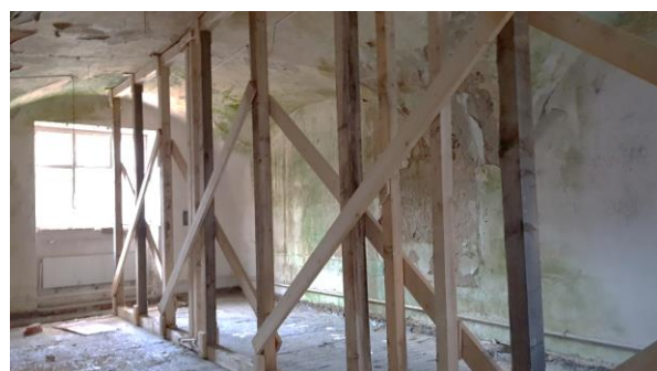
Obrázek 7, 8, 9, 10 – Provizorní podepření klenbové stropní konstrukce nad 1.n.p. v severním křídle při západní části
