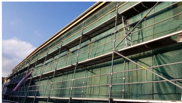
Obrázek 28, 29 – Užití ochranné sítě fasády a ochranného provizorního oplocení se zábořem chodníku kolem objektu v ulici Berkova a Zámecká
