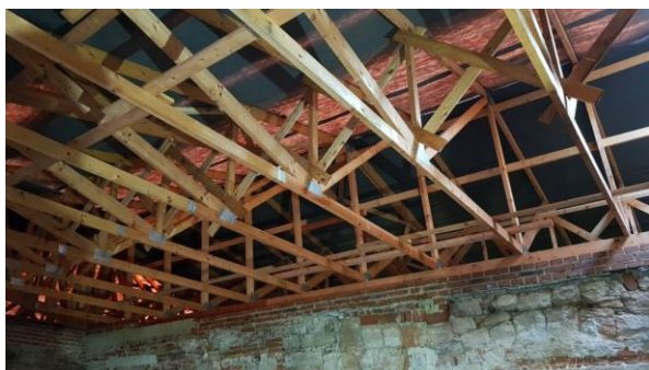
Obrázek 26, 27 – Provizorní zastřešení – lehká dřevěná sedlová konstrukce a pultová střecha nad schodištěm pomocí dřevěných sbíjených příhradových nosníků
