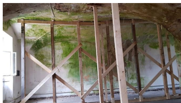
Obrázek 3, 4, 5, 6 – Provizorní podepření klenbové stropní konstrukce nad 1.n.p. v jižním křídle při západní části
