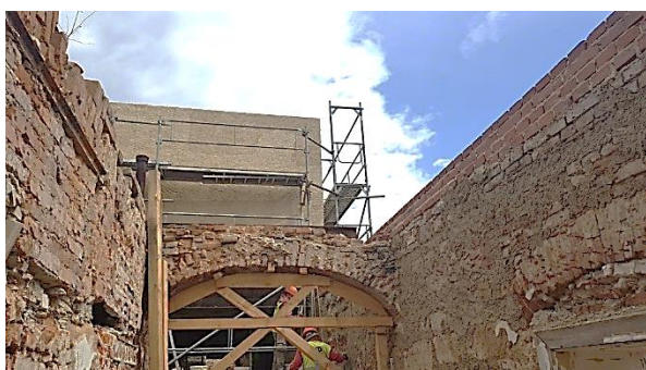
Obrázek 11, 12, 13, 14, 15 – Provizorní podepření kleneb konstrukce vnitřního schodiště mezi 1.n.p. až 3.n.p. a klenbových pásů nad 2.n.p.
