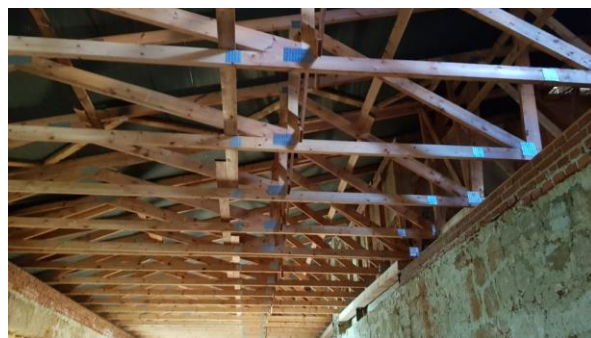
Obrázek 26, 27 – Provizorní zastřešení – lehká dřevěná sedlová konstrukce a pultová střecha nad schodištěm pomocí dřevěných sbíjených příhradových nosníků
