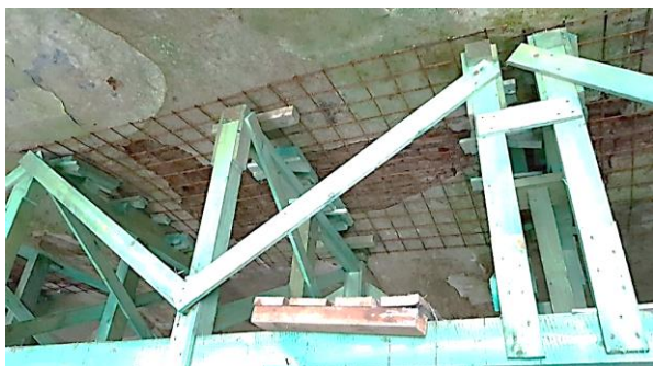
Obrázek 3, 4, 5, 6 – Provizorní podepření klenbové stropní konstrukce nad 1.n.p. v jižním křídle při západní části
