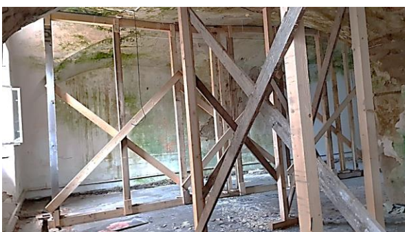
Obrázek 3, 4, 5, 6 – Provizorní podepření klenbové stropní konstrukce nad 1.n.p. v jižním křídle při západní části
