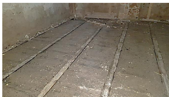
Obrázek 24, 25 – Odhalené dřevěné povaly s ponechanými ocelovými mechanickými spojovacími prostředky, nacházející se na stropních klenbových konstrukcích nad 1.n.p. v jižním křídle objektu
