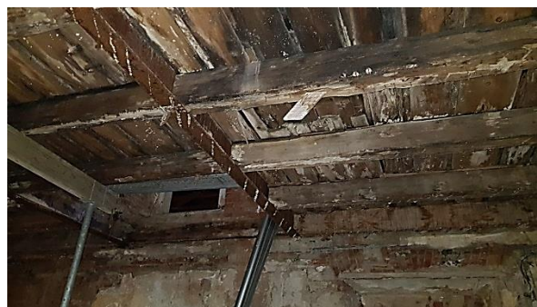
Obrázek 16, 17 – Provizorní podepření stropní konstrukce nad 2.n.p. – napadení dřevokaznou houbou a plísněmi
