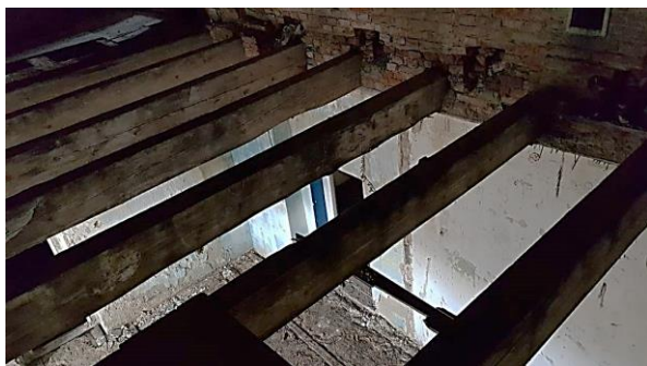
Obrázek 18, 19, 20, 21 – Provizorní lávka bez bezpečnostního zábradlí a bez pevného ukotvení na stávajících stropních konstrukcích nad 2.n.p. v centrální části objektu
