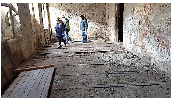
Obrázek 24, 25 – Odhalené dřevěné povaly s ponechanými ocelovými mechanickými spojovacími prostředky, nacházející se na stropních klenbových konstrukcích nad 1.n.p. v jižním křídle objektu
