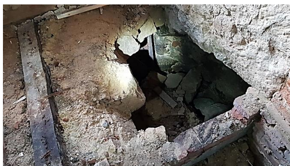
Obrázek 22, 23 – Zaslepený otvor ve stropní konstrukci nad 1.n.p. (kontrolní otvor pro zjištění původního historického schodiště při severní části severního křídla objektu)
