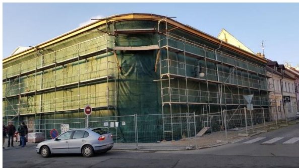
Obrázek 28, 29 – Užití ochranné sítě fasády a ochranného provizorního oplocení se zábořem chodníku kolem objektu v ulici Berkova a Zámecká
