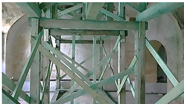
Obrázek 3, 4, 5, 6 – Provizorní podepření klenbové stropní konstrukce nad 1.n.p. v jižním křídle při západní části
