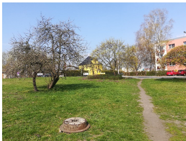
Nad terén vystupující kanalizační šachta
