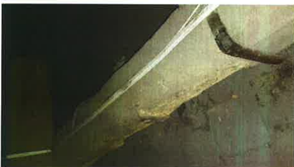
Obrázek 10, 11, 12, 13, 14, 15, 16, 17 – Pohled na nosné prvky konstrukce krovu z půdního prostoru nad 3.n.p., nad prostorem chodby ve 3.n.p. – stávající vazné trámy vykazují napadení a oslabení dřeva, přičemž vyvěšují stropní konstrukci nad 3.n.p. včetně podhledu pomocí ocelových kramlí – došlo ke vzniku nadměrného svislého průhybu a trhlin v omítkách podhledu nad 3.n.p.
