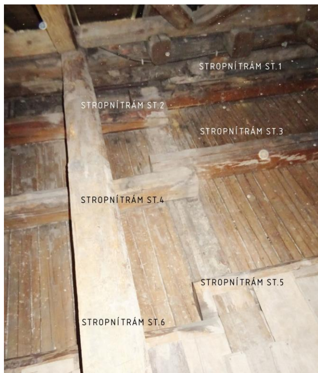
POZICE STROPNÍCH TRÁMŮ V SONDĚ NA ÚROVNI STŘEDNÍ NOSNÉ ZDI
