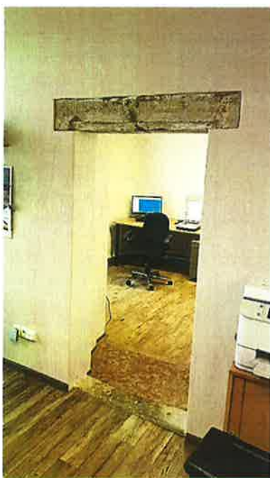
Obrázek 5, 6, 7 – Pohled dveřní otvor 2 kanceláří podatelny v 1.n.p. - trhliny v ostění a nadpraží
