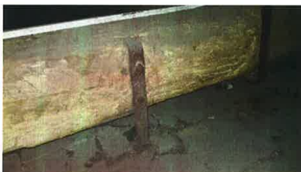
Obrázek 10, 11, 12, 13, 14, 15, 16, 17 – Pohled na nosné prvky konstrukce krovu z půdního prostoru nad 3.n.p., nad prostorem chodby ve 3.n.p. – stávající vazné trámy vykazují napadení a oslabení dřeva, přičemž vyvěšují stropní konstrukci nad 3.n.p. včetně podhledu pomocí ocelových kramlí – došlo ke vzniku nadměrného svislého průhybu a trhlin v omítkách podhledu nad 3.n.p.
