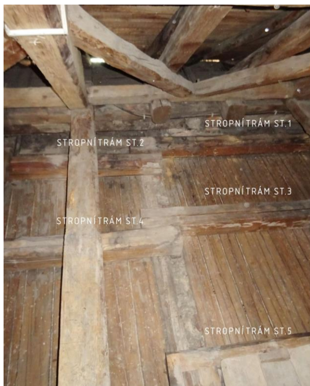
POZICE STROPNÍCH TRÁMŮ V SONDĚ NA ÚROVNI STŘEDNÍ NOSNÉ ZDI
