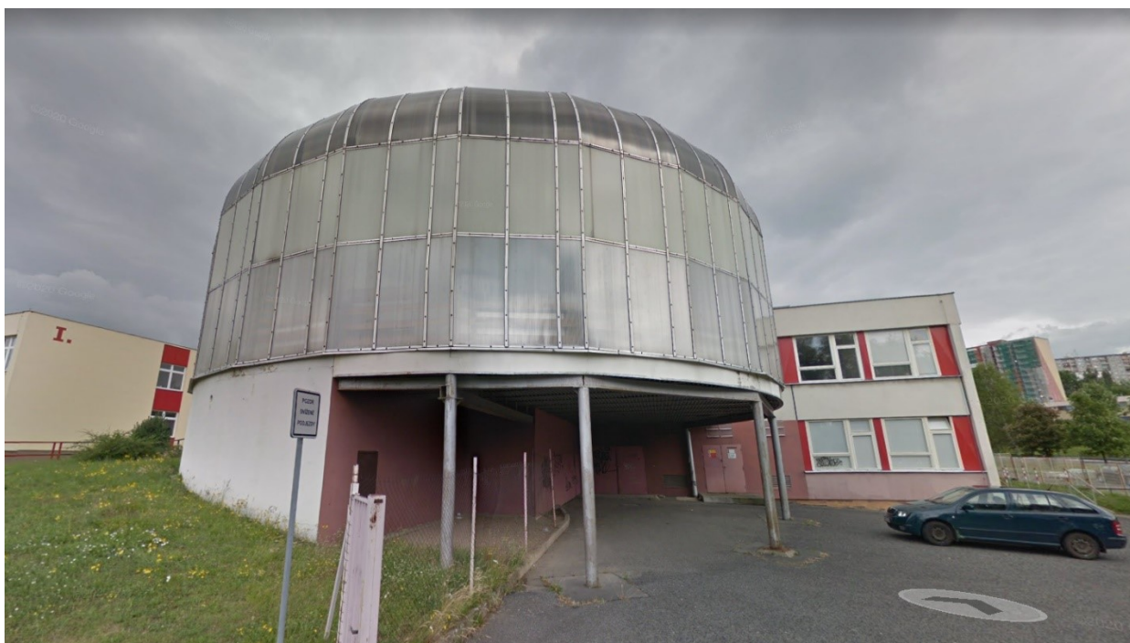
Pohled od jihu
