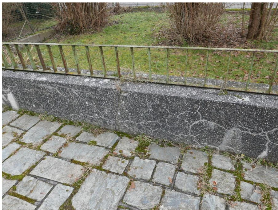
Výška opěrné 50 cm z terasy. Zřetelné trhlinky na povrchu zdi.
