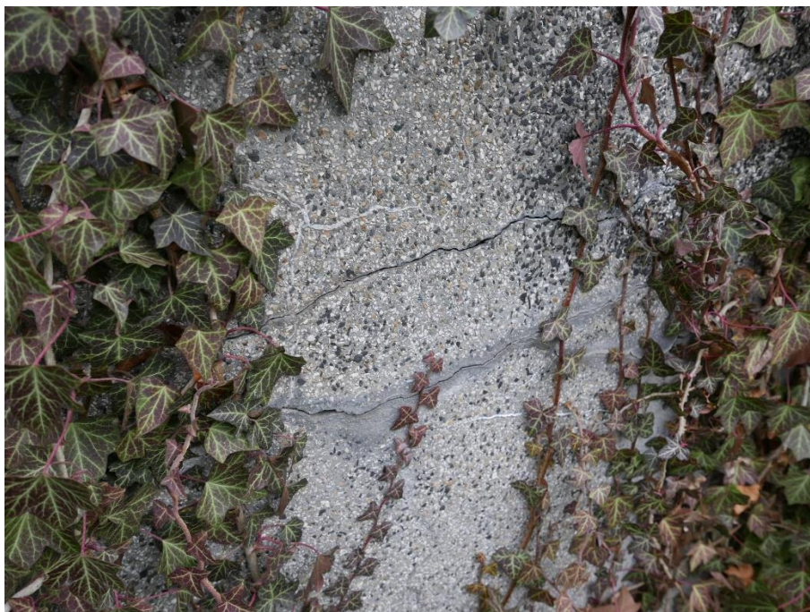
Poškození vodorovnou trhlinou v úrovni plochy terasy. To je odlišnou roztažností nadterasové části zdi. Přetáhnout perlínkou.
