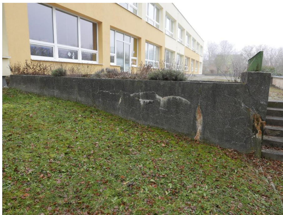
Poškození povrchu zdi u východního schodiště. Přetáhnout perlinkou.
