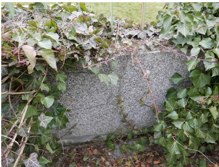
Svislá trhlina je přirozenou dilatační. Její šíře jen minimální. Přetáhnout perlínkou.
