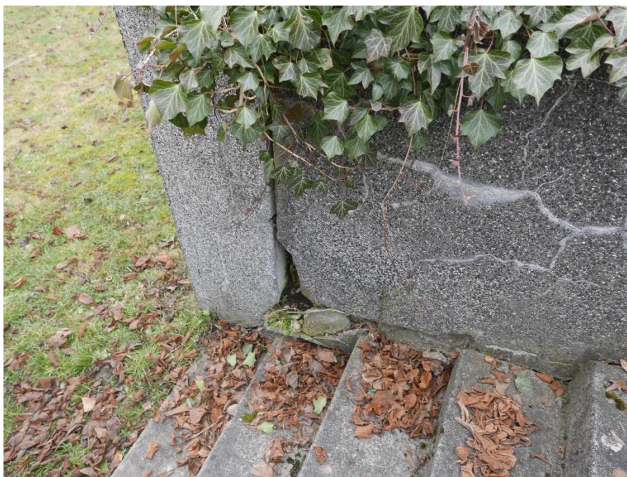
Poškození schodišťové zdi u východního schodiště. Otvor je možný dolepit směsí flexibilního lepidla a písku.
