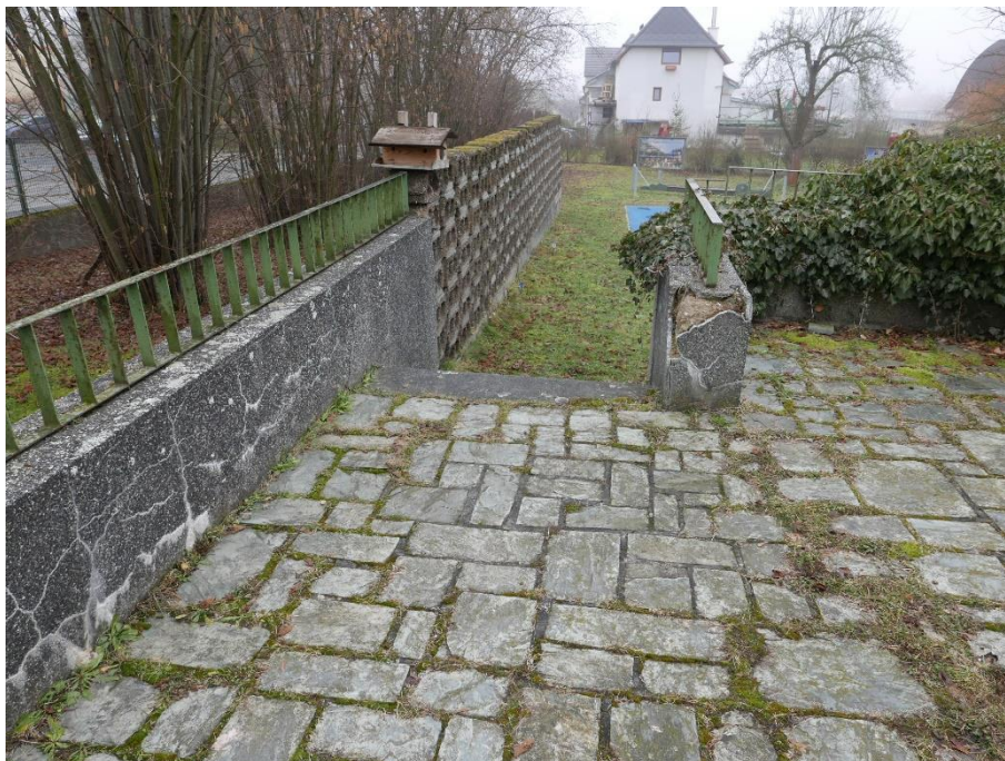
Poškození nadezdívky u východního schodiště. Povrch je možný dolepit směsí flexibilního lepidla a písku.
