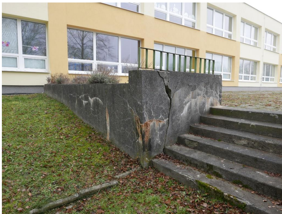
Poškození schodišťové zdi u východního schodiště. Nároží je třeba odbourat a znovu dobetonovat s přikotvením do původní masy betonu.
