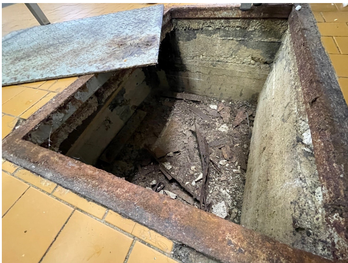
Foto č. 4 stávající stav bezodtokové jímky
