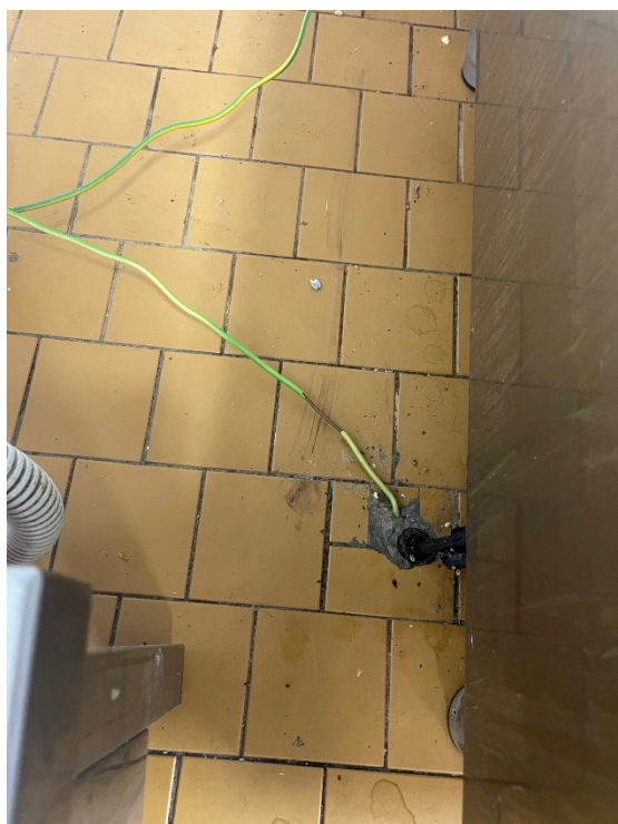
Foto č. 10,11,12,16 – úprava elektro rozvodů
