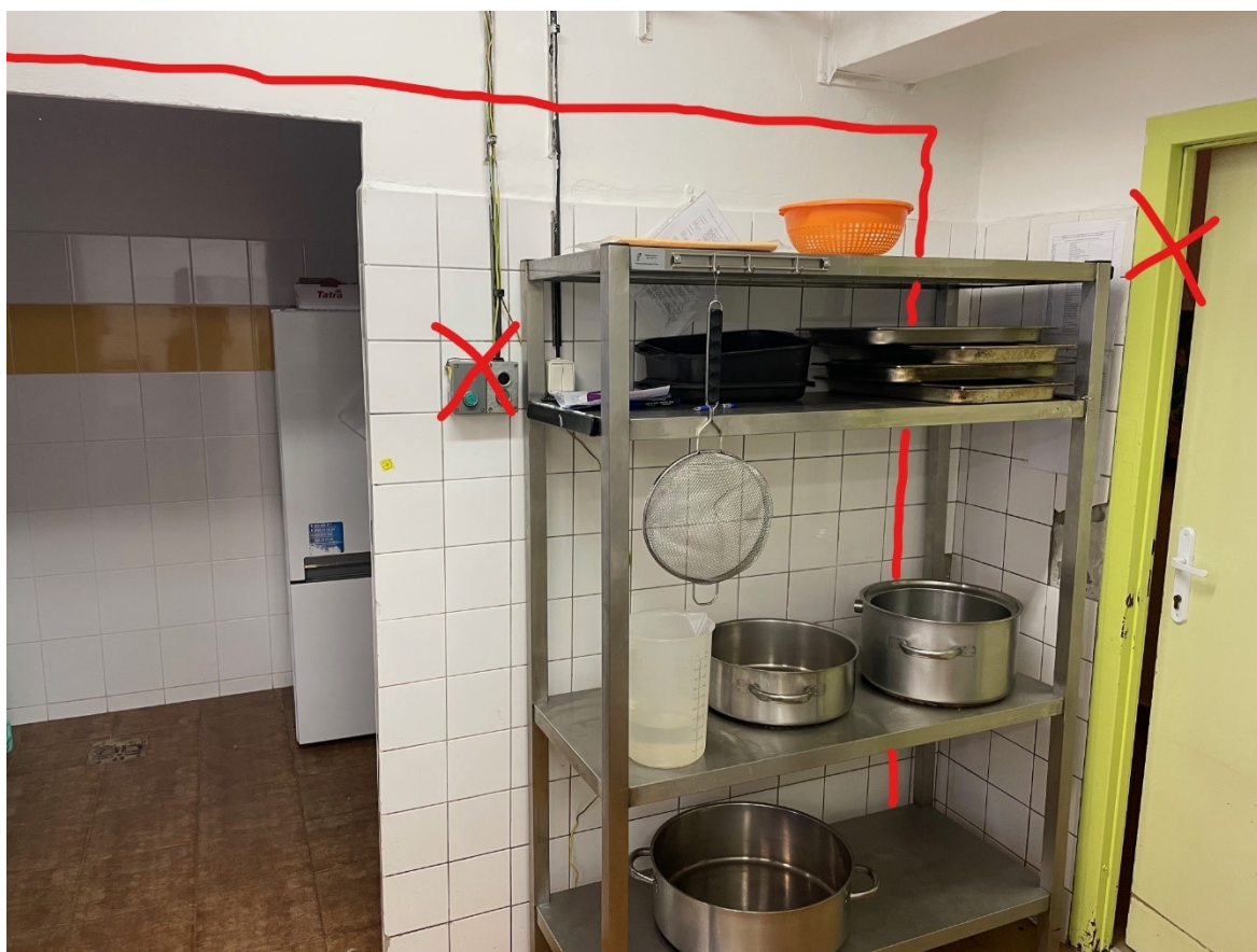
Foto č. 5, 6 – část příčky určená k demolici s následným začištěním
