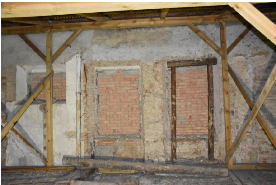
Pohled k západu na zajištěné zdivo severního průčelí patra a ruby kleneb překryté pultovým provizorním zastřešením.
