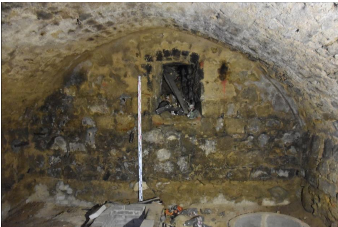
Klenební čelo sklepa (v SHP z roku 2007 pod číslem 5) s větracím oknem.
