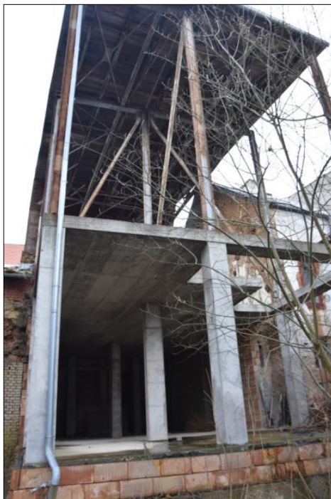
Konstrukce zajišťující průčelí čp. 158 a relikv hradby s přilehlým klenutým sklepem.
