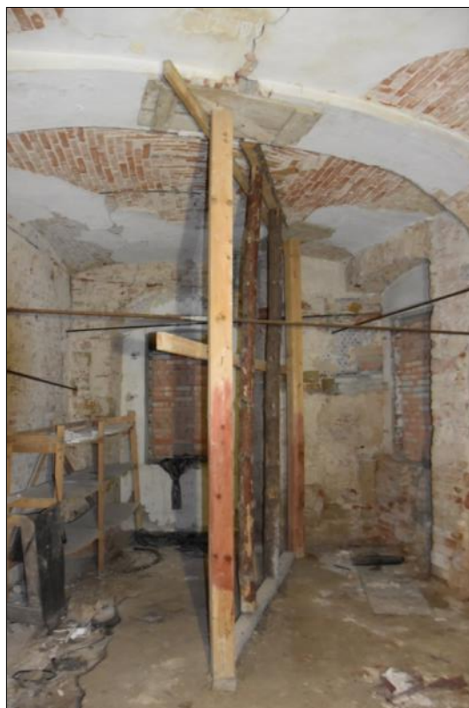
Pohled do místnosti č. 18 s placovými klenbami s meziklenebním pasem z druhé poloviny 19. století.
