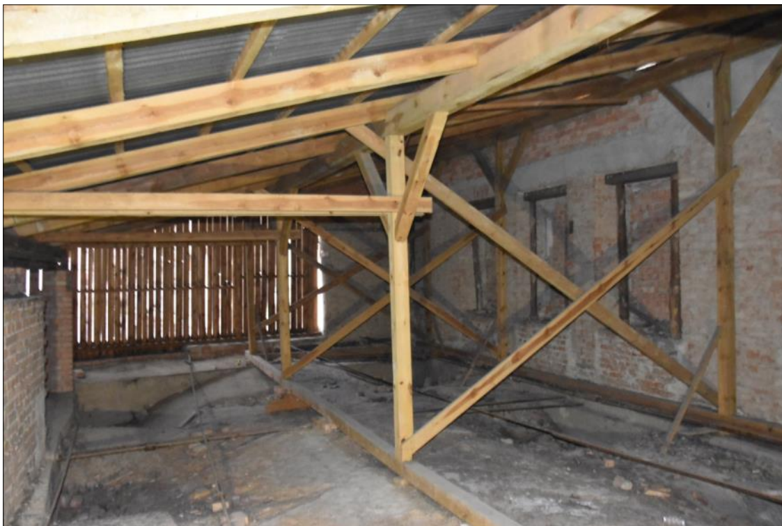
Pohled k západu na zajištěné zdivo severního průčelí patra a ruby kleneb překryté pultovým provizorním zastřešením.
