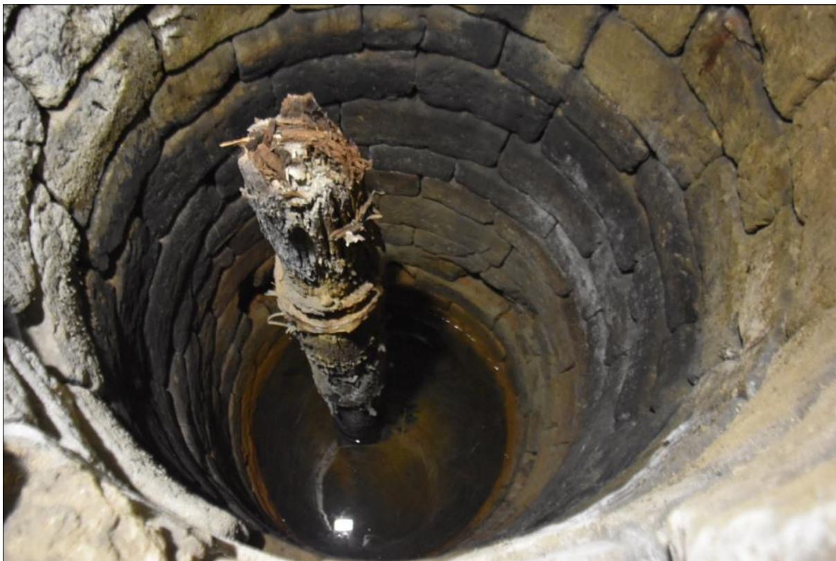
Dřevěné potrubí s kovovými spojkami v tubuse studny mezi sklepem č. 3 a 4.
