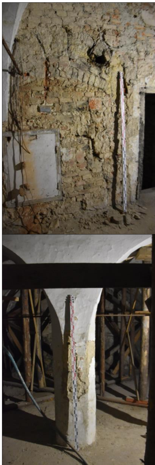
Zazděné otvory po otopném zařízení v koutě místnosti č. 12 a klasicistní pilíř mladšího klenutého pasu vydělující místnost č. 12 a 13.
