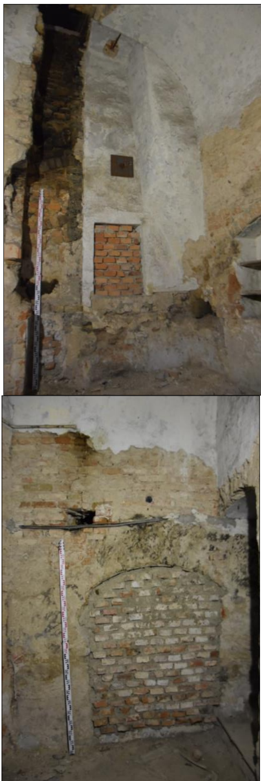
Stopy vývoje otopných zařízení pod starším dymníkem a nika zazděná v západní stěně.
