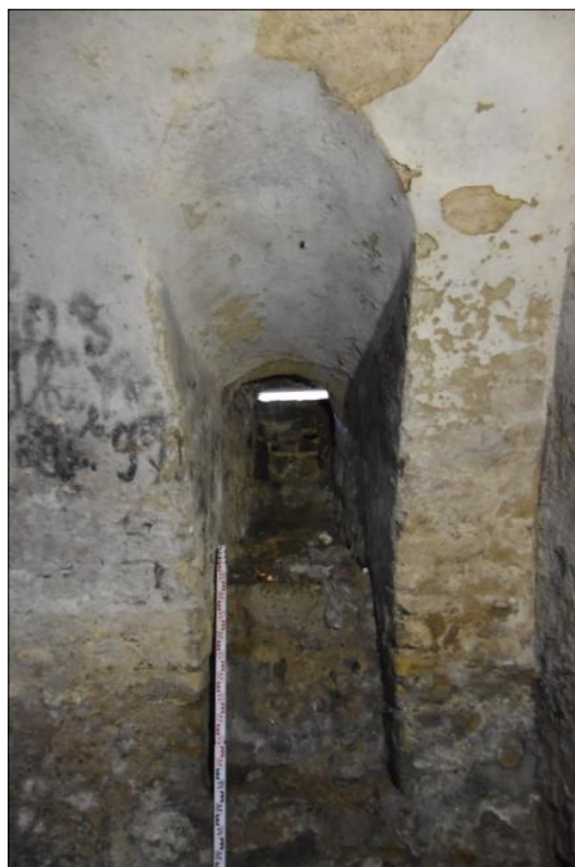
Pětiboká výseč v klenbě nad větracím sklepním oknem ve sklepi č. 2.
