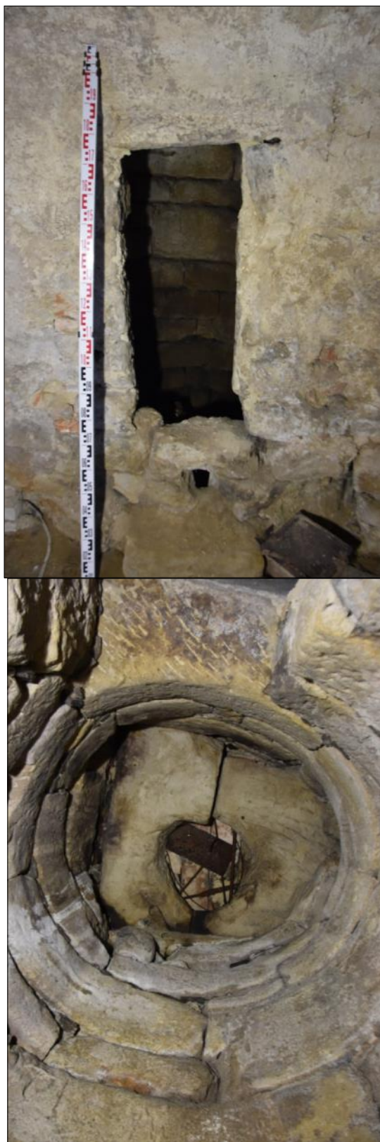
Otvor v plášti studny ve sklepe č. 3 a pohled tubusem studny nahoru.
