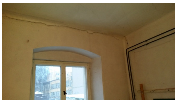
Obr.6,7 – Pohled na trhliny v interiéru zadní západní části přístavby stávajícího domu č.p.172 – trhlina mezi obvodovou stěnou a podhledem stropní konstrukce nad 1.n.p.
