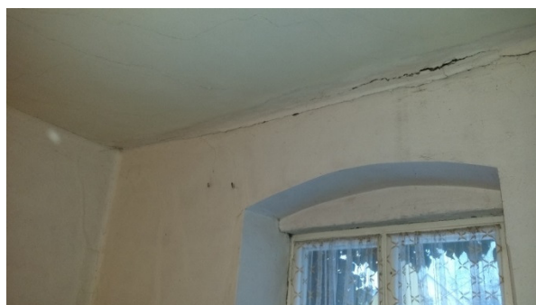
Obr.6,7 – Pohled na trhliny v interiéru zadní západní části přístavby stávajícího domu č.p.172 – trhlina mezi obvodovou stěnou a podhledem stropní konstrukce nad 1.n.p.
