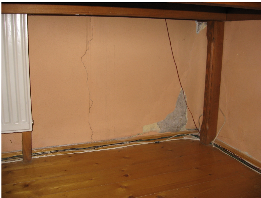
Obr.8 – Pohled na trhliny v interiéru objektu zadní západní části přístavby stávajícího domu č.p.172
