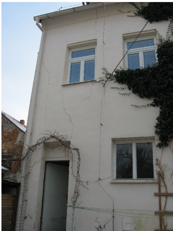
Obr.2 – Pohled na zadní část posuzovaného domu č.p.172 v ulici náměstí T.G.M. v České Lípě od západu – vizuálně viditelné trhliny charakterizující pravidlo kolmice – prokazující sedání severozápadního rohu budovy
